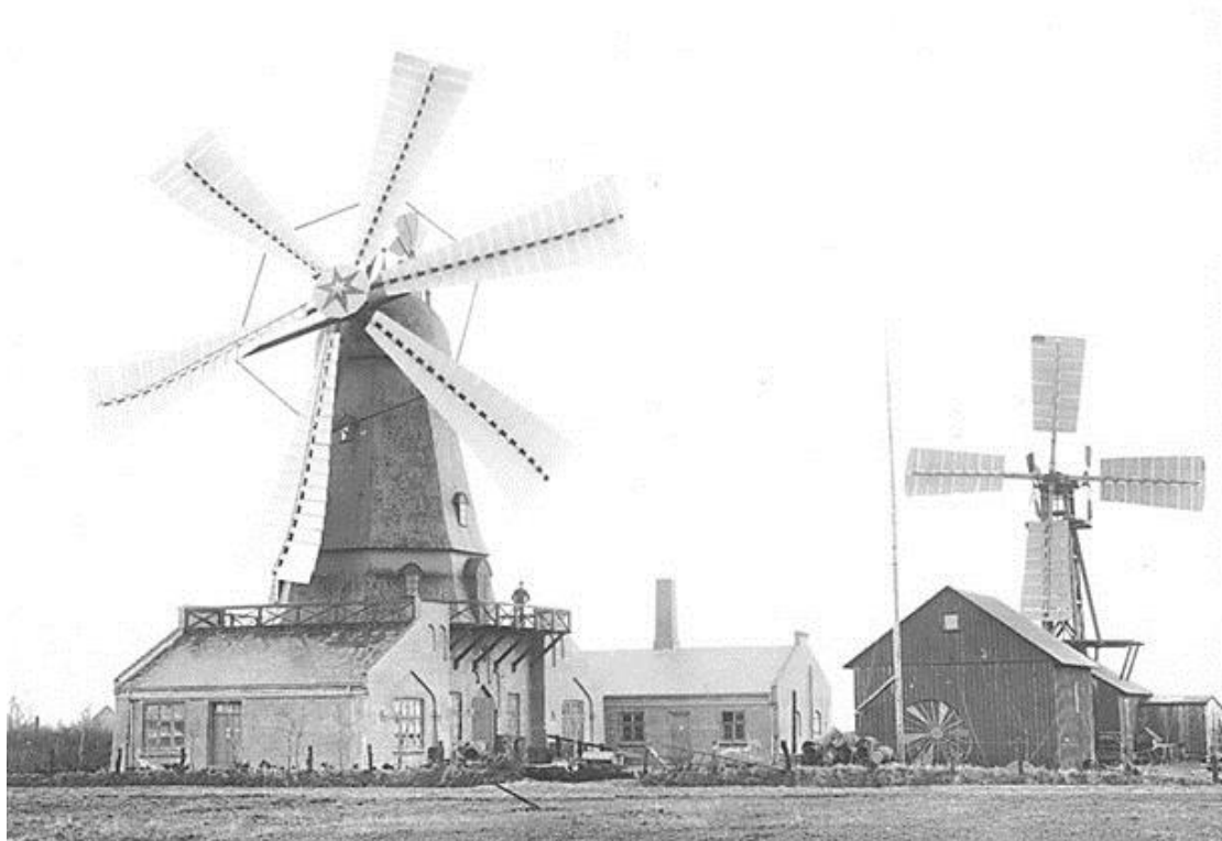
Εικόνα 3.1.1: Η πρώτη πειραματική ανεμογεννήτρια στην περιοχή Askov της Δανίας το 1897 Πηγή: http://www.roullacour.dk/ (πρόσβαση 21/2/2015)
