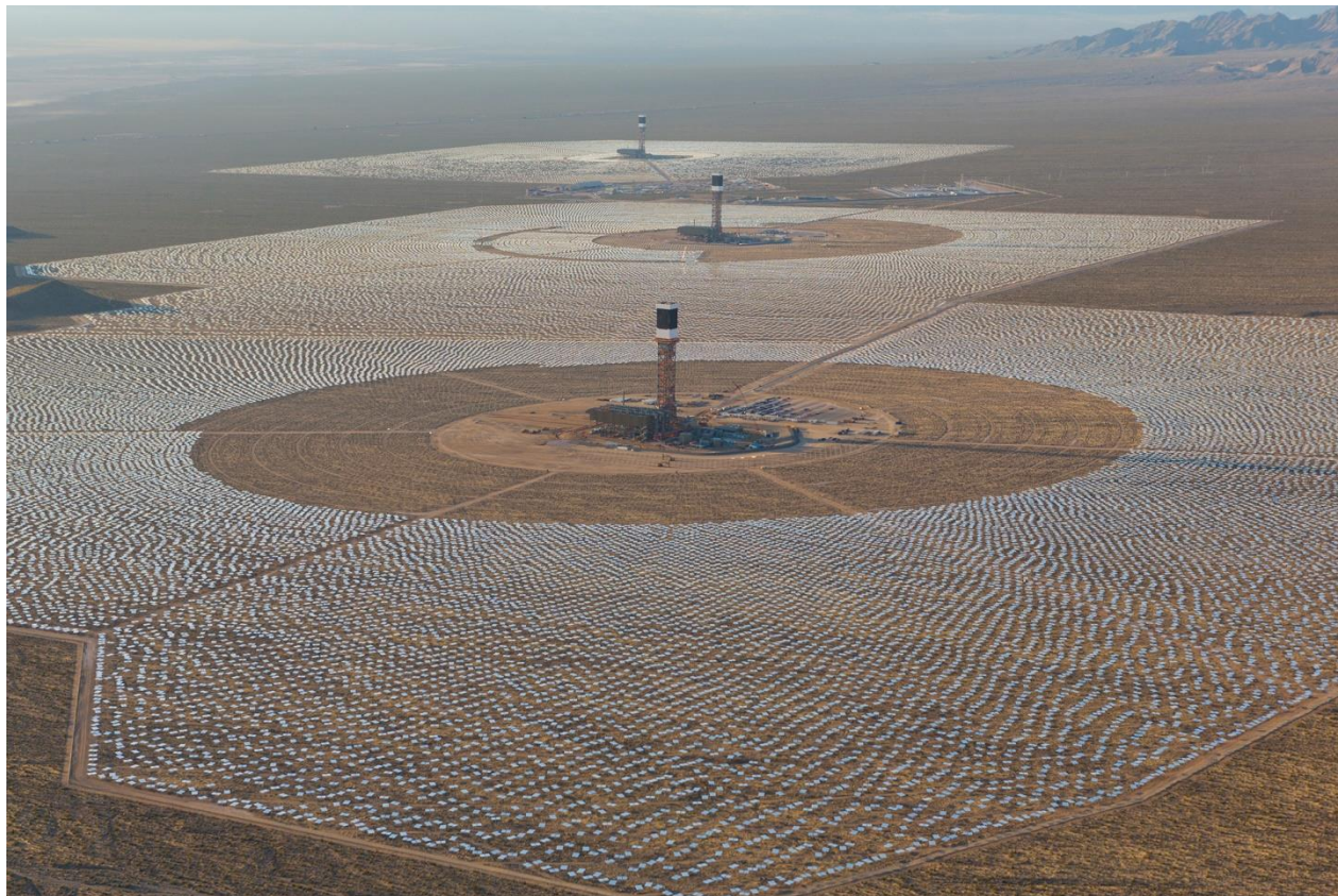
Εικόνα 1.2.1: Ivanpah, το μεγαλύτερο ηλιακό πάρκο που κατασκευάστηκε στην έρημο Mojave στην Νεβάδα της Αμερικής Πηγή:
