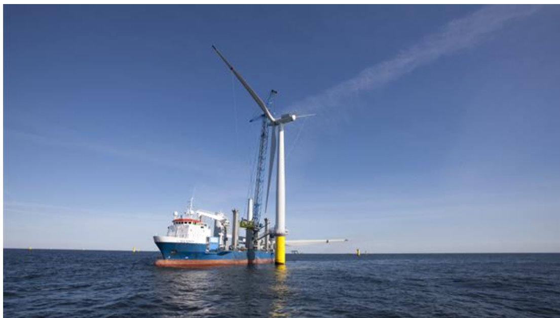
Εικόνα 4.1.5: Η πρώτη ανεμογεννήτρια τοποθετείται, 19 Μαρτίου 2009 Πηγή: www.hornsrev2.com (πρόσβαση 17/1/2015)
