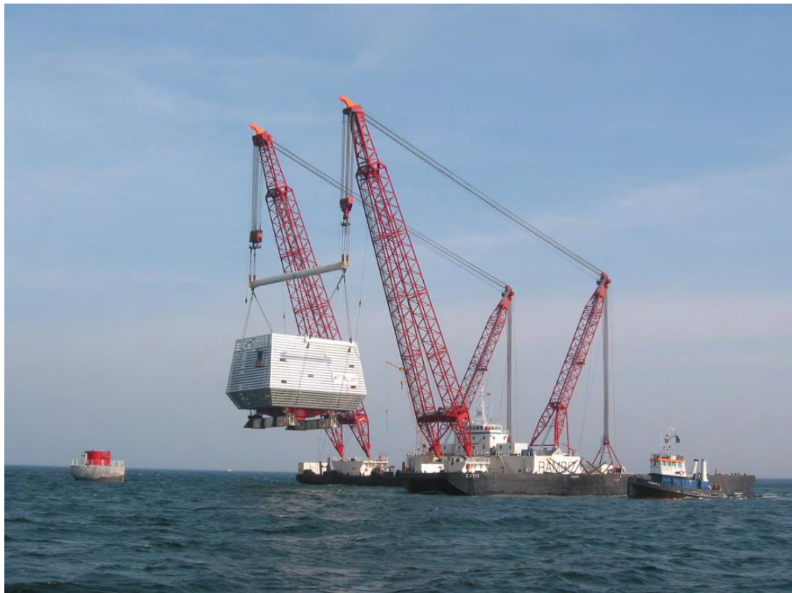
Εικόνα 4.2.2: Τοποθέτηση του υποσταθμού στην θάλασσα Πηγή: (Nysted Off-Shore Windfarm, Jan Havsager) (πρόσβαση 21/1/2015)
