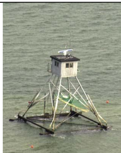
Σχήμα 5.5.1: Αυτός ο πύργος είχε χρησιμοποιηθεί και σε παλιότερες μετρήσεις στο αιολικό πάρκο στο Tunø Knob και τοποθετήθηκε 5 χιλιόμετρα μακριά από το Horns Rev Photo: Jonas Teilmann Πηγή: (Christensen T. K. κ. συν. 2004)
