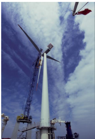
Εικόνα 4.1.2: Ανεμογεννήτρια πριν την τοποθέτηση της στο Horns Rev Πηγή: Kjær J.I. κ. Συν. 2006
