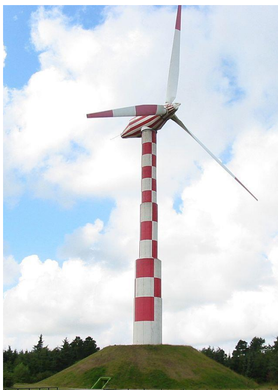
Εικόνα 3.1.3: Η ανεμογεννήτρια στο Tvind Πηγή: Wikipedia Tvind (πρόσβαση 23/2/2015)
