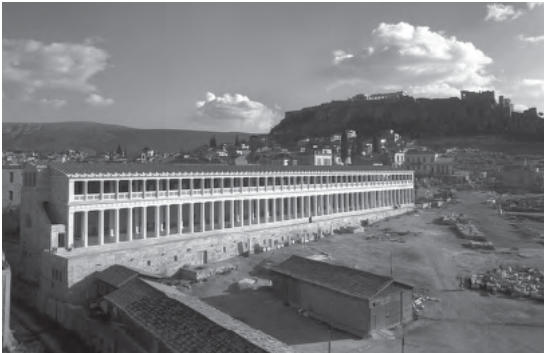
Εικόνα 4.2.: Η Στοά του Αττάλου μετά την αναστήλωση (1956).
