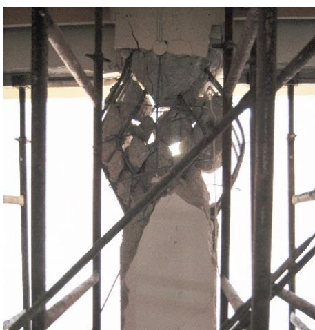
Εικόνα 4-18 Τυπική μορφή βλάβης βαθμού Δ
