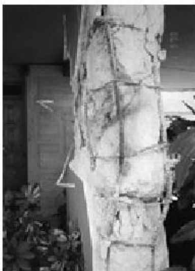
Σχήμα 1-3 Διακοπή συνέχειας υποστυλώματος λόγω πλήρους αποδιοργάνωσης του σκυροδέματος και βλάβης του διαμήκους και εγκάρσιου σπλισμού
