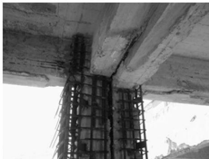
Σχήμα 3-14 Κατασκευή ανοικτού μανδύα υποστυλώματος στην περιοχή αντισεισμικού αρμού
