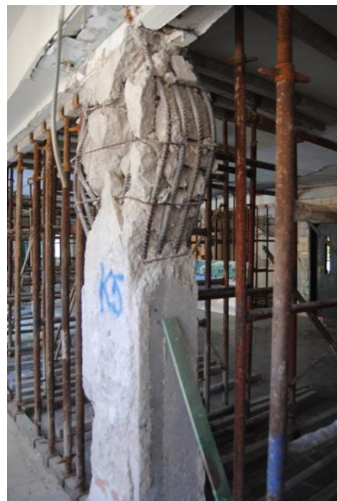
Εικόνα 4-15 Αστοχία με διακοπή της συνέχειας στοιχείου στην κρίσιμη περιοχή υποστυλώματος και κόμβου
