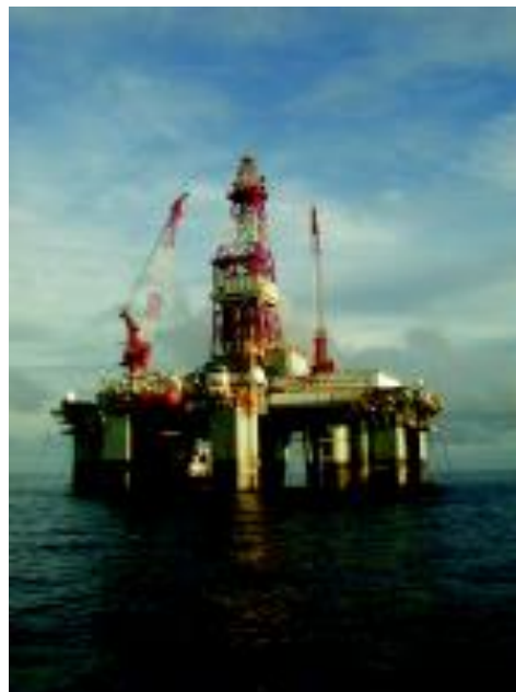
Εικ. 1.17 Ocean Baroness, μια από τις ημιβυθισμένες εξέδρες κατηγορίας Ocean Victory δεύτερης γενιάς που αναβαθμίστηκε σε πέμπτης γενιάς. Παρατηρήστε τις επιπλέον στήλες άνωσης (blisters), την επέκταση του καταστρώματος και τους πολύ μεγαλύτερους πύργους γεώτρησης. Σε αυτήν την εξέδρα στη Μαλαισία το 2003 έγιναν έργα προστασίας από έκρηξη (BOP work). Επίσης κατέρριψε το παγκόσμιο ρεκόρ βάθους νερού (2030 m) με κατανεμημένο σύστημα αυτόνομης αγκύρωσης (self-contained spread-mooring) [10].
