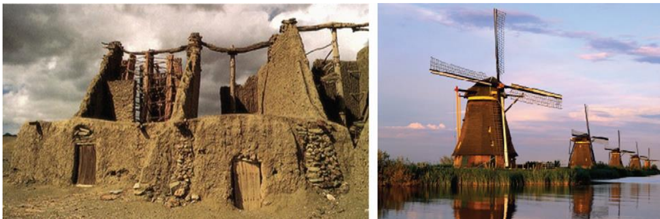
Εικ. 1.30 Περσικές μηχανές άλεσης με κατακόρυφο άξονα (αριστερά) και οι ανεμόμυλοι με οριζόντιο άξονα των Ολλανδών (δεξιά) [20].
