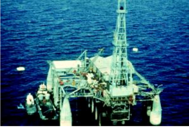
Εικ. 1.13 Εξέδρα Bluewater No.1, η πρώτη ημιβυθισμένη MODU στον κόσμο, μετατράπηκε το 1961/1962 από την Shell Oil από μια βυθισμένη εξέδρα. Καταστράφηκε το 1964 [10].
