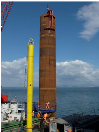
Εικ. 1.43 Στήριξη μονού πυλώνα (monopile) [43.]
