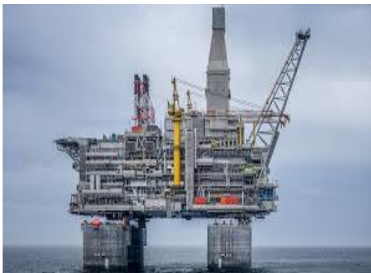
Εικ. 1.24 Η εξέδρα Berkut στη ρωσική ακτή του ειρηνικού ωκεανού. Αποτελεί τη μεγαλύτερη πλωτή κατασκευή στον κόσμο και ζυγίζει πάνω από 200.000 tn χωρίς τη βάση της [11].
