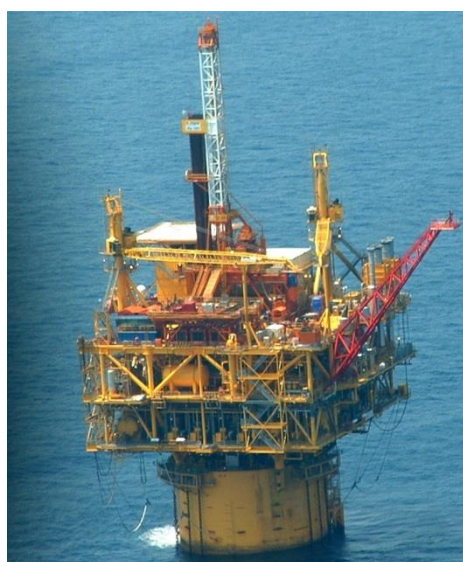
Εικ. 1.21 Η εξέδρα Devil's Tower στον κόλπο του Μεξικού. Αποτελεί εξέδρα τύπου Spar και η κατασκευή του ολοκληρώθηκε στο τέλος του 2003. Είναι φανερή η στήριξη του καταστρώματος στον κατακόρυφο κύλινδρο [11].
