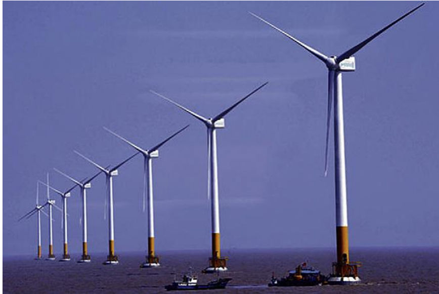
Εικ. 1.42 Υπεράκτιο αιολικό πάρκο Donghai Bridge στη Shanghai της Κίνας [42].
