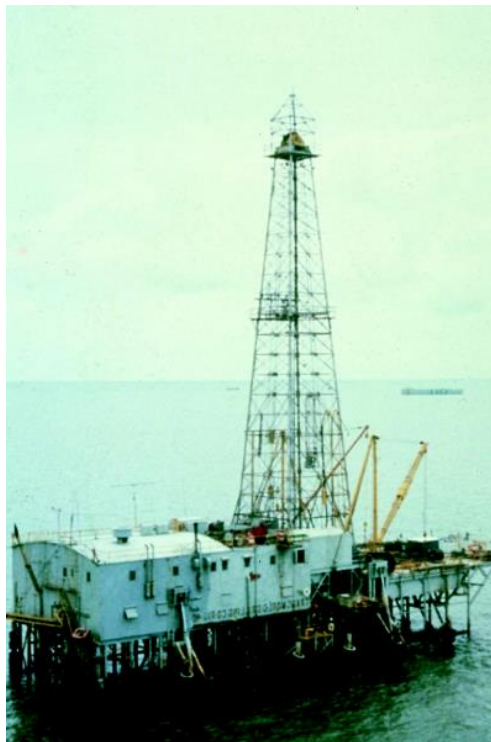
Εικ. 1.1 Εξέδρα Breton 20, κατασκευάστηκε στα νερά της Λουιζιάνας το 1949. Λειτουργήσε μέχρι το 1962 [4] .
