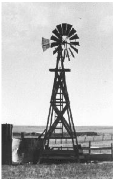
Εικ. 1.31 Ένας ανεμόμυλος με χαλύβδινα πτερύγια που χρησιμοποιείτο για άντληση στις Η.Π.Α. προς το τέλος του 19 ου αι [21].
