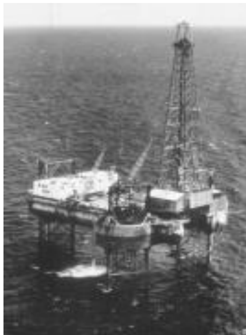
Εικ. 1.11 Εξέδρα Scorpion της Le Tourneau, κατασκευάστηκε για την τότε Zapata (τώρα Diamond Offshore Drilling Inc.) το 1956 σε βάθος νερού περίπου 26 m. Ήταν jack-up πλατφόρμα με ανεξάρτητα πόδια με δικτυώματα. Αποσύρθηκε το 1969 [9].
