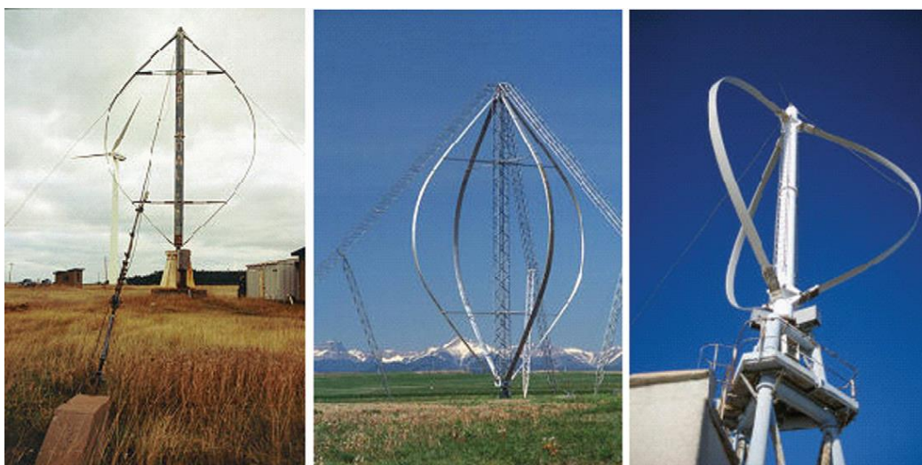
Εικ. 1.32 Μορφές των ανεμογεννητριών κατακόρυφου άξονα (γνωστοί ως ανεμογεννήτριες “eggbeater”-εξάρτημα που χτυπάει αυγα) που εφηύρε ο Darrieus το 1931 [23].
