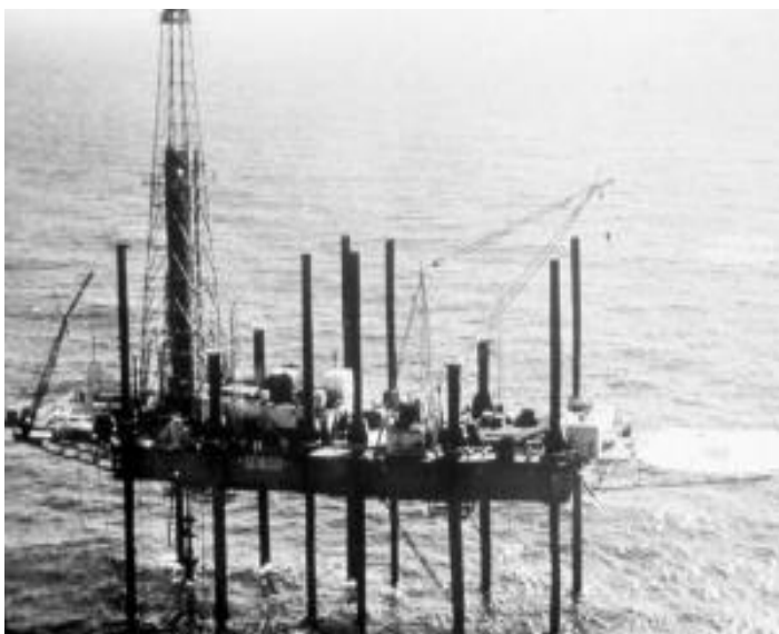
Εικ. 1.10 Η εξέδρα Gus I, με σύστημα στήριξης τύπου De Long, κατασκευάστηκε το 1954 σε βάθος νερού περίπου 33 m, και αποτελεί τον πρόδρομο των σύγχρονων jack-up εξεδρών. Καταστράφηκε τελικά σε μία καταιγίδα [9].
