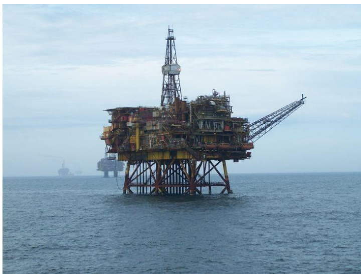
Εικ. 1.6 Η εξέδρα Brent A στο πεδίο του Brent της Βόρειας θάλασσας, σχεδιασμένη με δυνατότητα πλεύσης (Self floating Jacket) [4].
