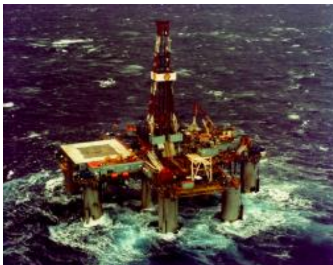
Εικ. 1.15 Ημιβυθισμένη εξέδρα δεύτερης γενιάς της κατηγορίας Ocean Victory. Η εν προκειμένω είναι η Ocean Voyager, εγκατεστημένη στη Βόρεια θάλασσα στις αρχές του 1970. Αυτός ο σχεδιασμός αποδείχτηκε πολύ ελκυστικός για αναβάθμιση σε εξέδρα τέταρτης και πέμπτης γενιάς [10].
