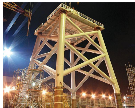
Εικ. 1.46 Στήριξη τύπου Jacket [43].
