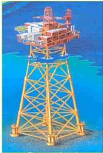
Εικ. 1.3 Τυπική μορφή εξέδρας “Jacket” [6].
