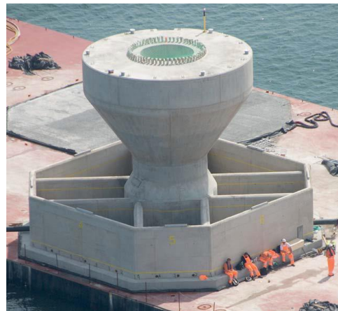
Εικ. 1.44 Βάση βαρύτητας (gravity base) [43].
