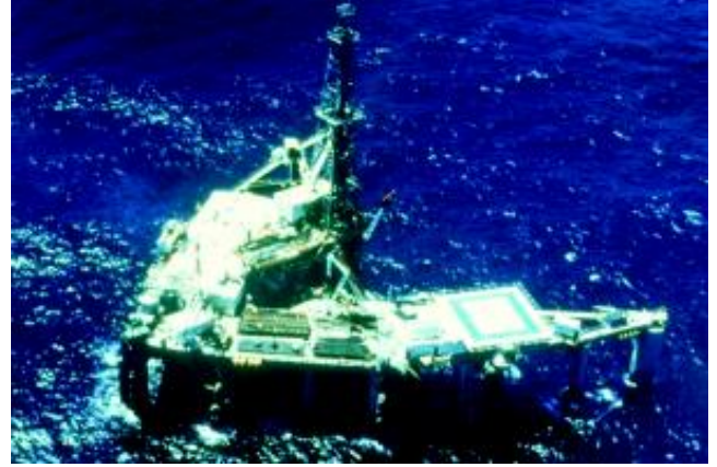
Εικ. 1.14 Πρώτη σκόπιμα κατασκευασμένη ημιβυθισμένη MODU, Η εξέδρα Ocean Driller ανεγέρθη το 1963. Μπορούσε να λειτουργήσει και σαν βυθισμένη πλατφόρμα. Αποσύρθηκε το 1992 [10].
