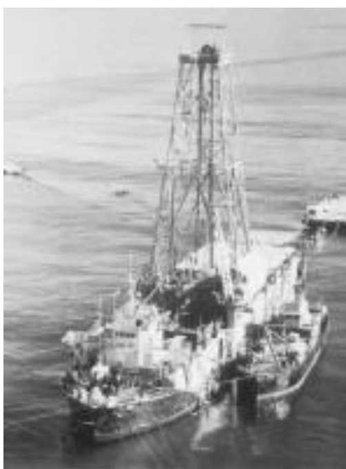
Εικ. 1.7 Western Explorer, η πρώτη (1955) πλεύουσα εξέδρα γεώτρησης τύπου MODU που χρησιμοποιούσε υποθαλάσσιο έλεγχο του πηγαδιού. Αποσύρθηκε το 1972 [6].
