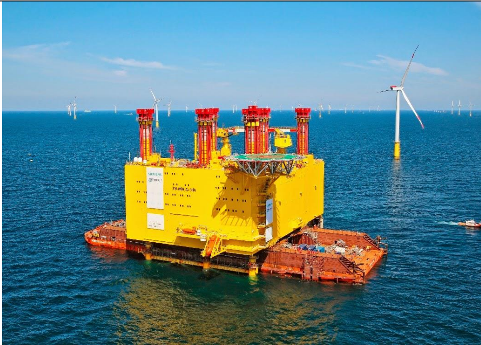
Εικόνα 3.24 Υπεράκτιος σταθμός μετατροπής SylWin Alpha platform Siemens
