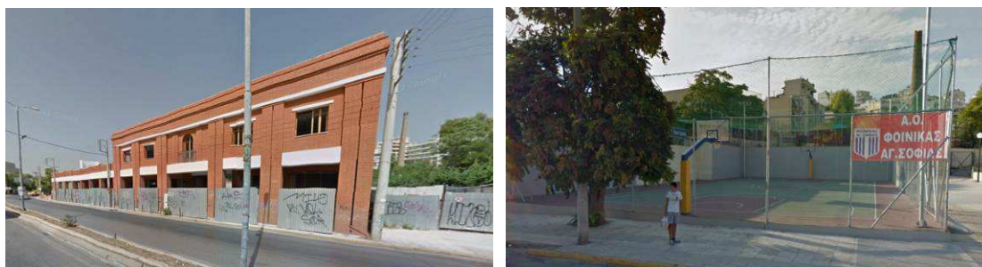
Εικόνες 2.65 και 2.66: Αριστερά ο βρεφονηπιακός σταθμός που κατασκευάζεται και δεξιά το γήπεδο μπάσκετ. (Πηγή: Επεξεργασμένες εικόνες από το Google Street View)
