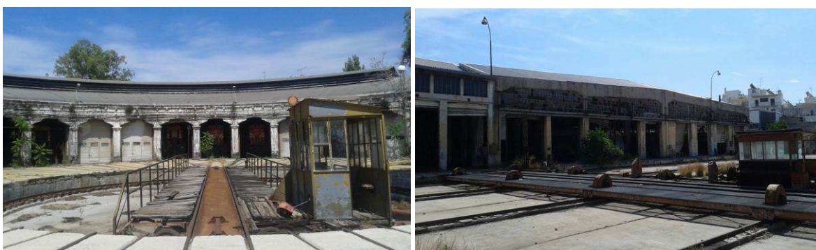
Εικόνες 2.74 και 2.75: Κτίρια του παλιού Μηχανοστασίου. Αριστερά το Κυκλικό Μηχανοστάσιο και δεξιά κτίρια όπου πλέον αποθηκεύονται παλαιοί συρμοί. (Πηγή: Ίδια επεξεργασία, 3/6/2015)
