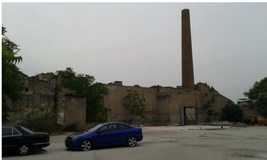
Εικόνα 3.17: Το κτίριο του του παλιού Κλωστοϋφαντουργείου με την πανύψηλη καμινάδα που προτείνεται να ανακατασκευαστεί σε Μουσείο Εργατικής και Βιομηχανικής Ιστορίας. (Πηγή: Ίδια επεξεργασία, 3/6/2015)
