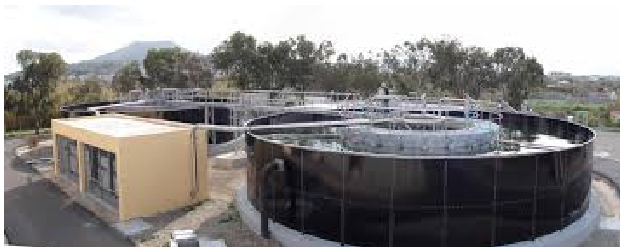
Εικόνα 3: Συμβατικό σύστημα Ενεργούς Ιλύος (EI)
