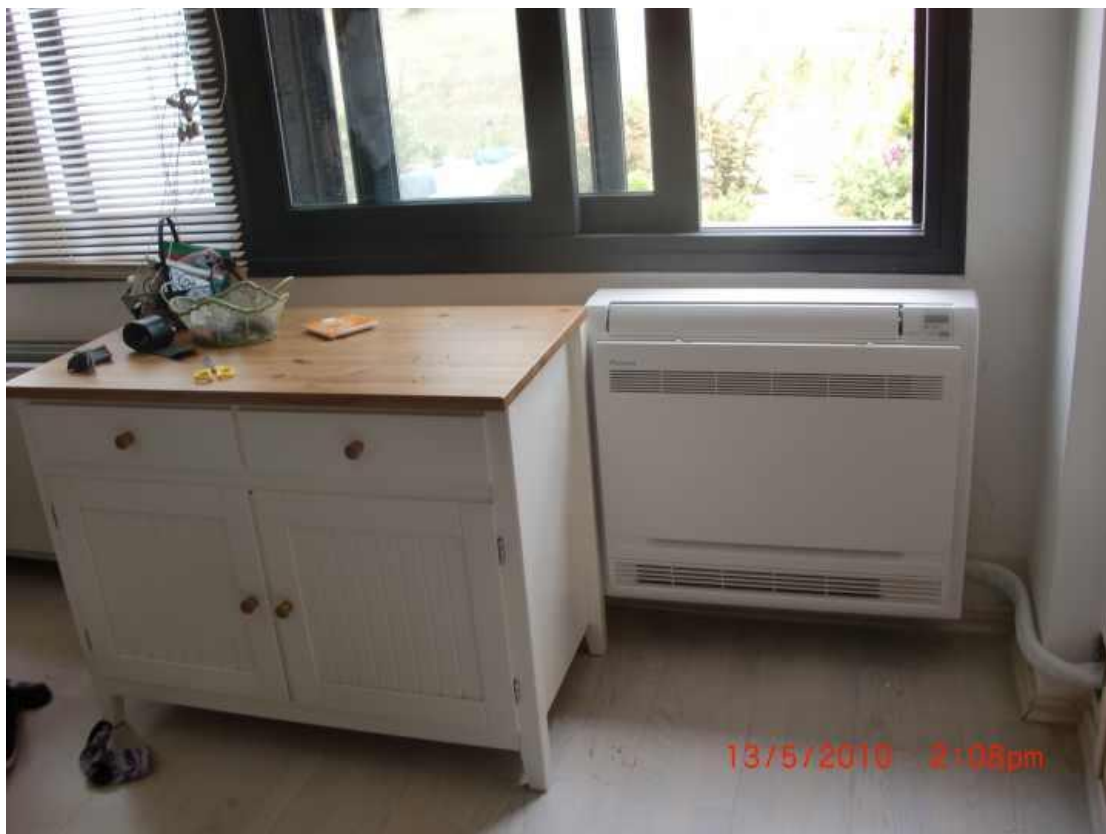
Εικόνα 1.23. Fan coil δαπέδου (τοποθετημένο δίπλα σε παράθυρο)
