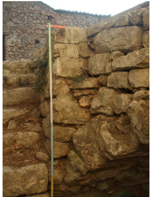
Εσωτερική τοιχοποιία σκάλας ανόδου
