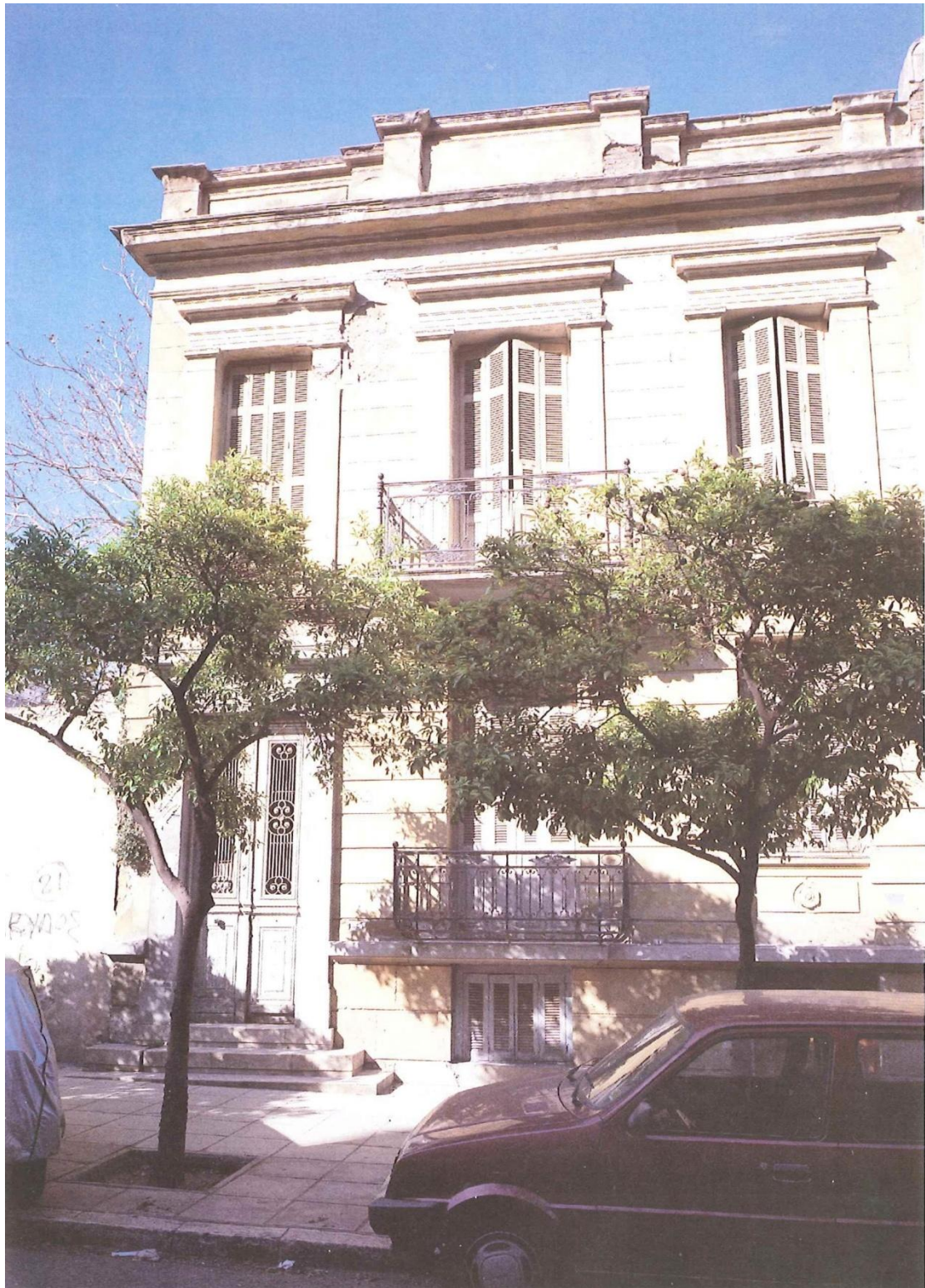
Εικόνα 46. Οικία επί της οδού Χαρίλαου Τρικούπη.
