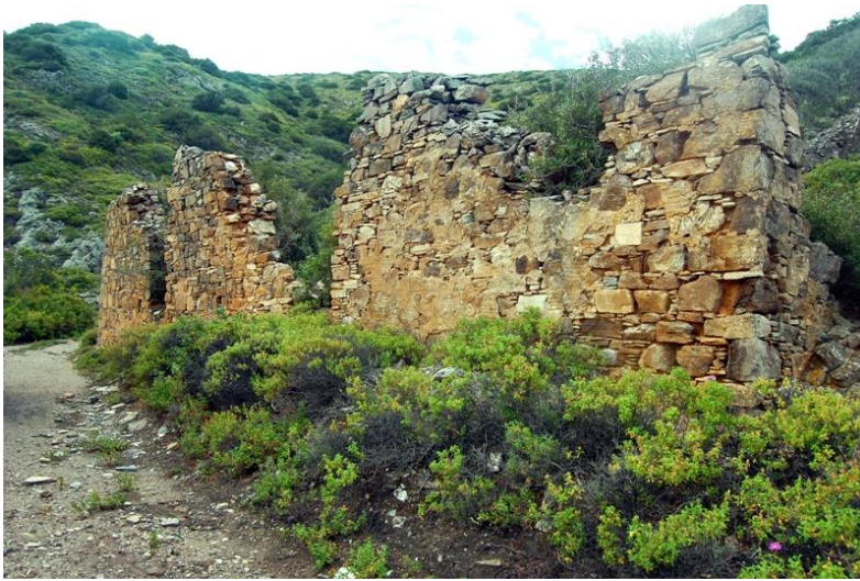
Εικόνα 9.13 : Πρόσθια όψη κτίσματος στο Σ1
