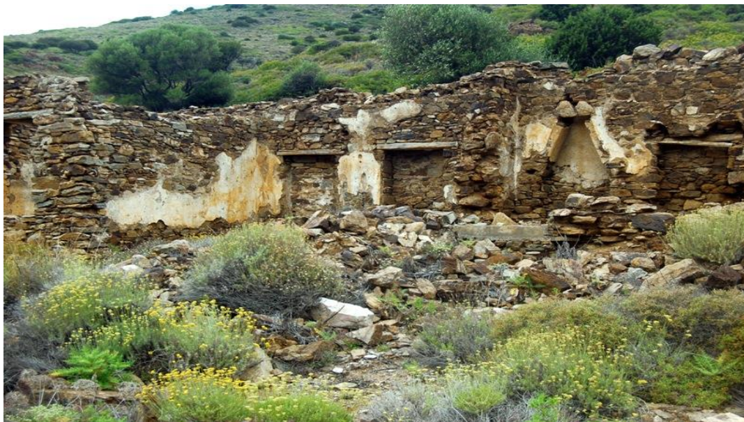
Εικόνα 9.29: Άποψη του εσωτερικού χώρου του κτίσματος στη θέση Σ3
