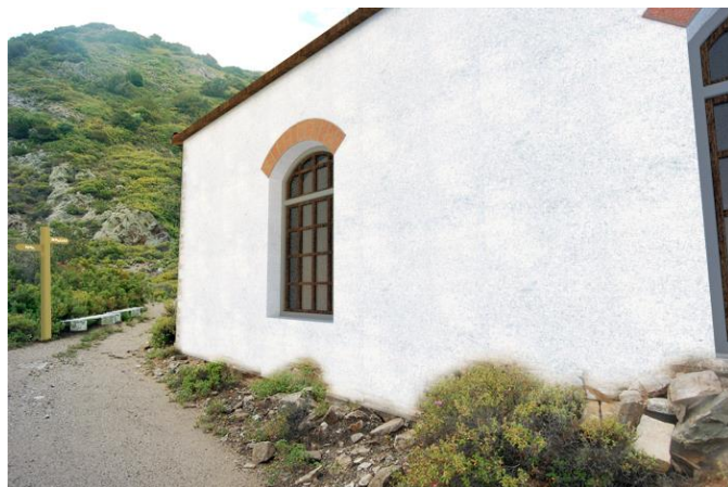
Εικόνα 8: Ανακατασκευή με επίχρισμα
