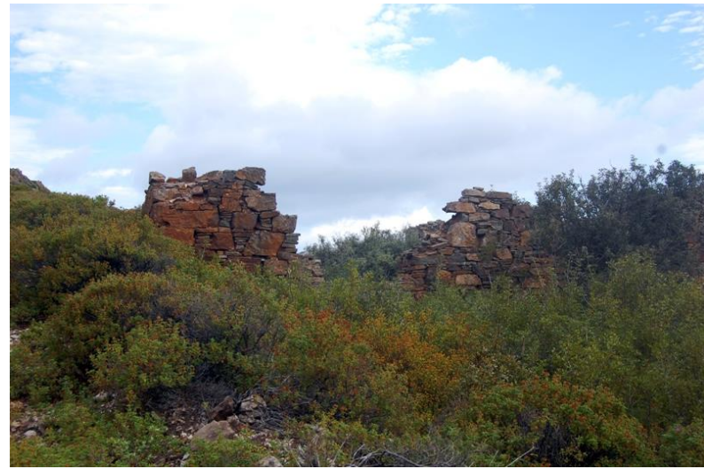
Εικόνα 9.14 : Τμήμα οπίσθιας όψης κτίσματος στο Σ1
