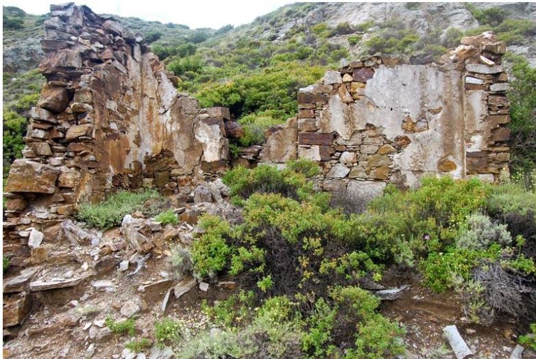
Εικόνα 9.15 : Λιθοδομή κτίσματος στο Σ2
