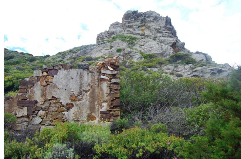
Εικόνα 9.16 : Λεπτομέρεια λιθοδομής κτίσματος στο Σ2
