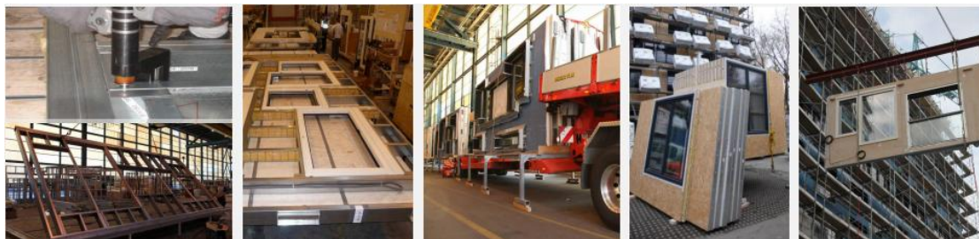
Εικόνα 1.2: Προκατασκευασμένα μέρη κτιρίου ξηράς δόμησης
