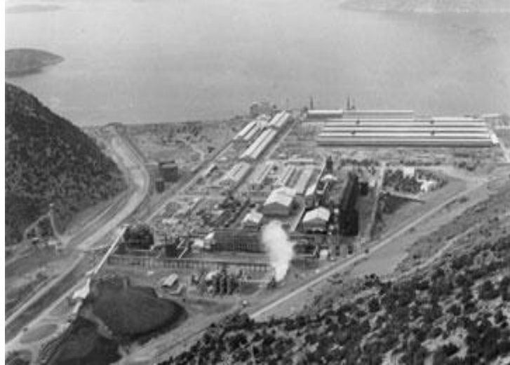
Εικόνα 4. Έναρξη εργασιών του εργοστασίου
