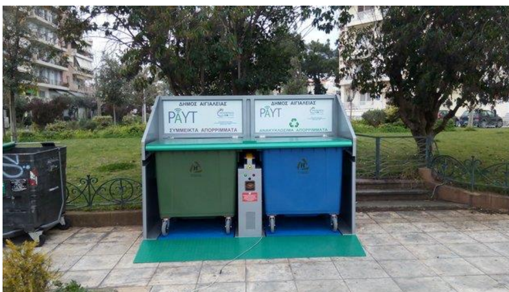
Εικόνα 6.4 : Εγκατάσταση πιλοτικού συστήματος στην πλατεία Υψηλών Αλωνιών
