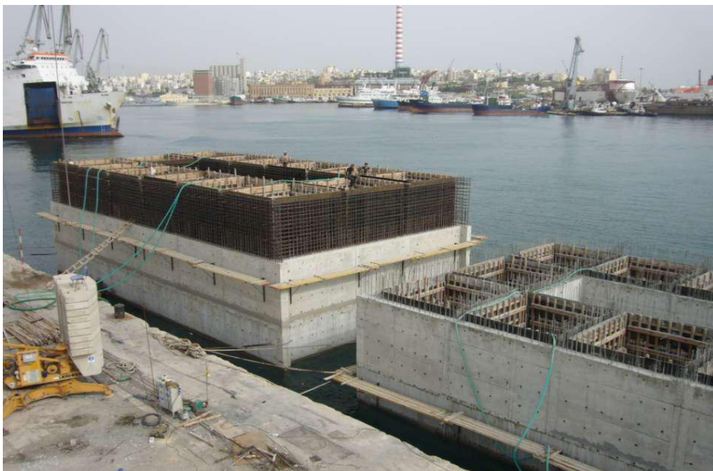
Εικόνα 22 : Κατασκευή του caisson εν πλω. ( www.kgrgroup.gr )
