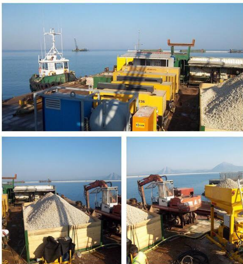
Εικόνα 17 : Το υλικό πλήρωσης των χαλικοπασσάλων και ο εξοπλισμός που χρησιμοποιούνται στο έργο του Νέου Λιμένα Πατρών.
