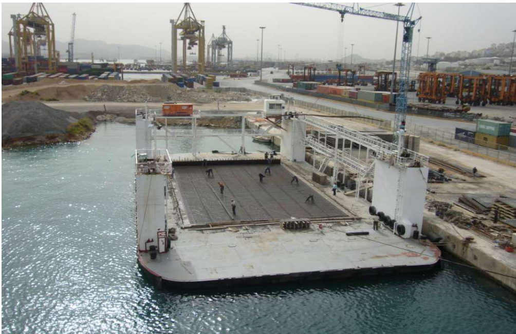
Εικόνα 20 : Πλωτή αυτοβυθιζόμενη φορηγίδα (caissoniera).
