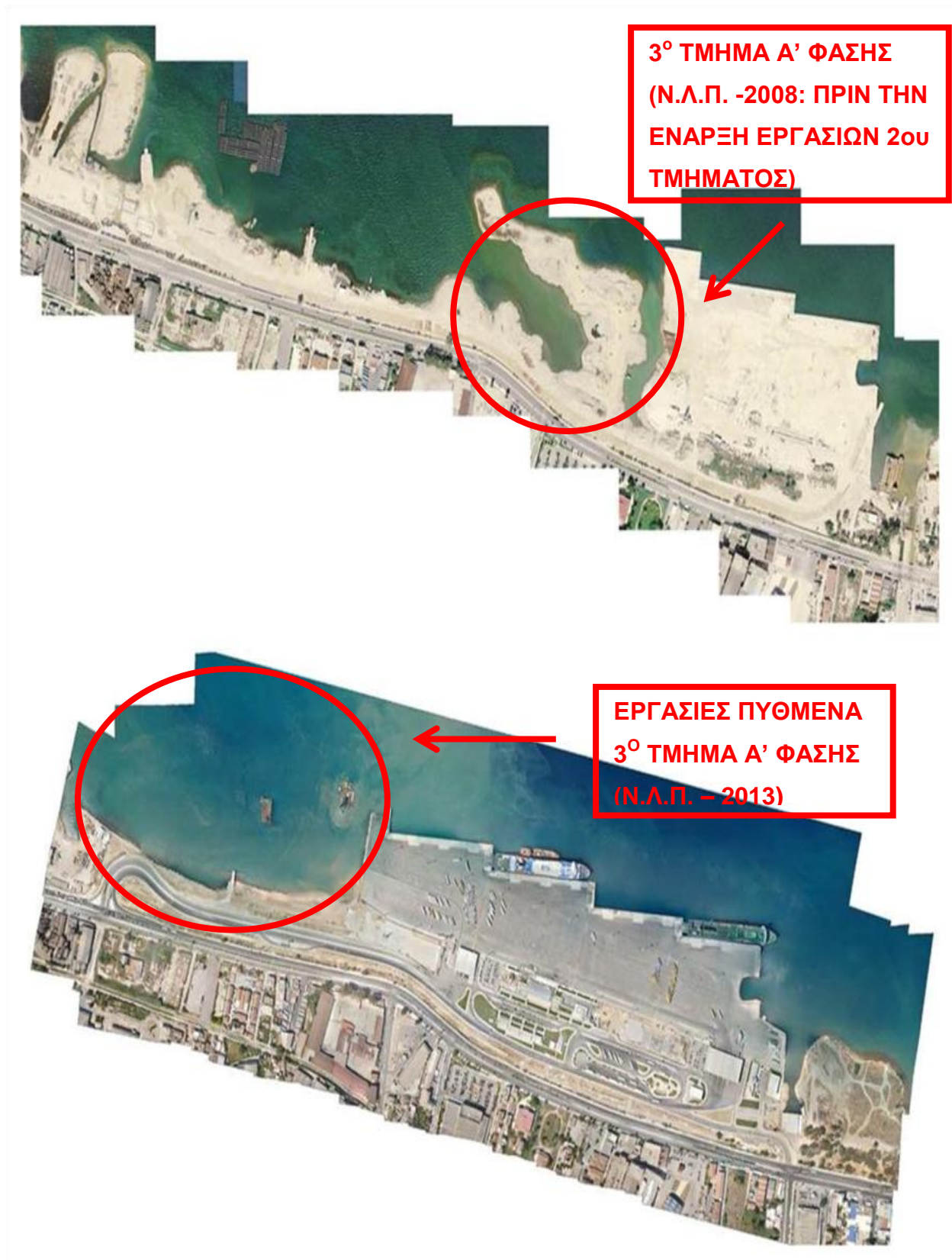
Εικόνα 8 : Αεροφωτογραφίες πριν και κατά τη διάρκεια των εργασιών του 3ου τμήματος της Α' φάσης.
