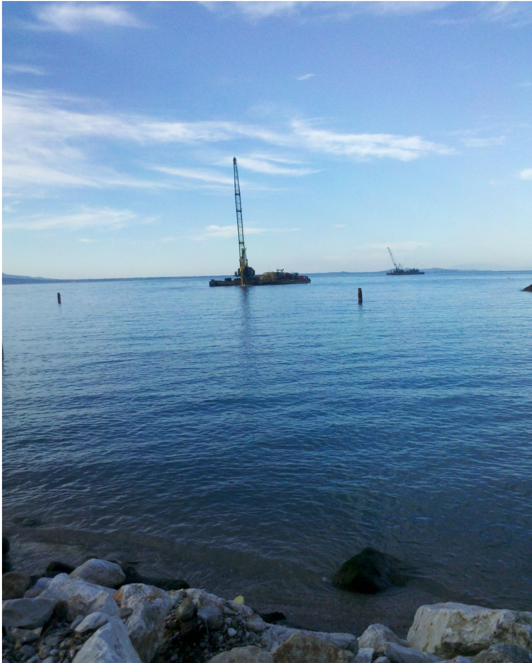
Εικόνα 18 : Πλωτός γερανός κατά τη διάρκεια κατασκευής χαλικοπασσάλων.
