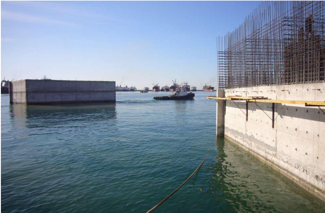
Εικόνα 23 : Το caisson κατά τη μεταφορά του με ρυμουλκό.
