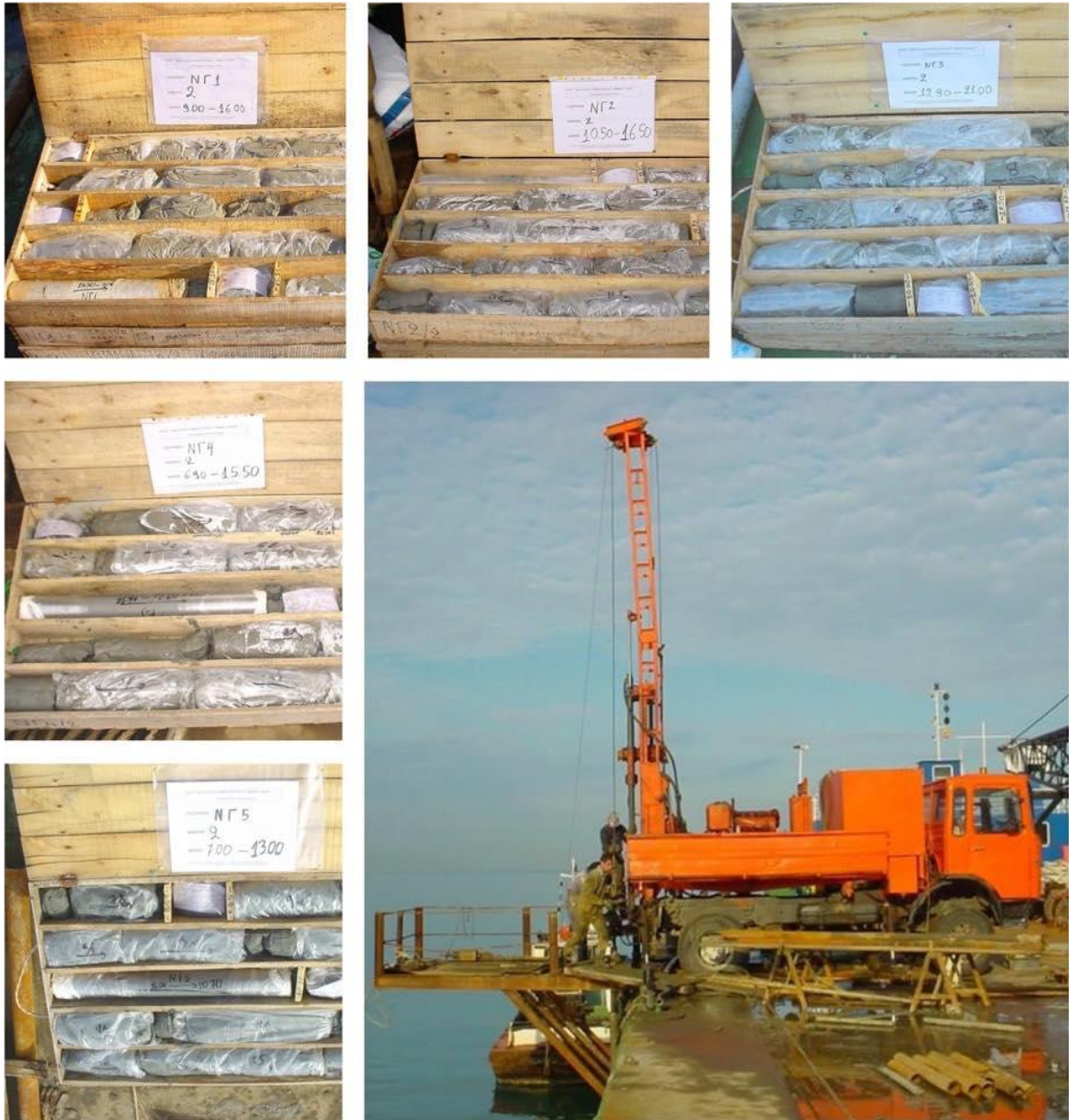
Εικόνα 10 : Ενδεικτικά κασελάκια των ερευνητικών γεωτρήσεων και τα μηχανήματα εκτέλεσης των γεωτρήσεων.
