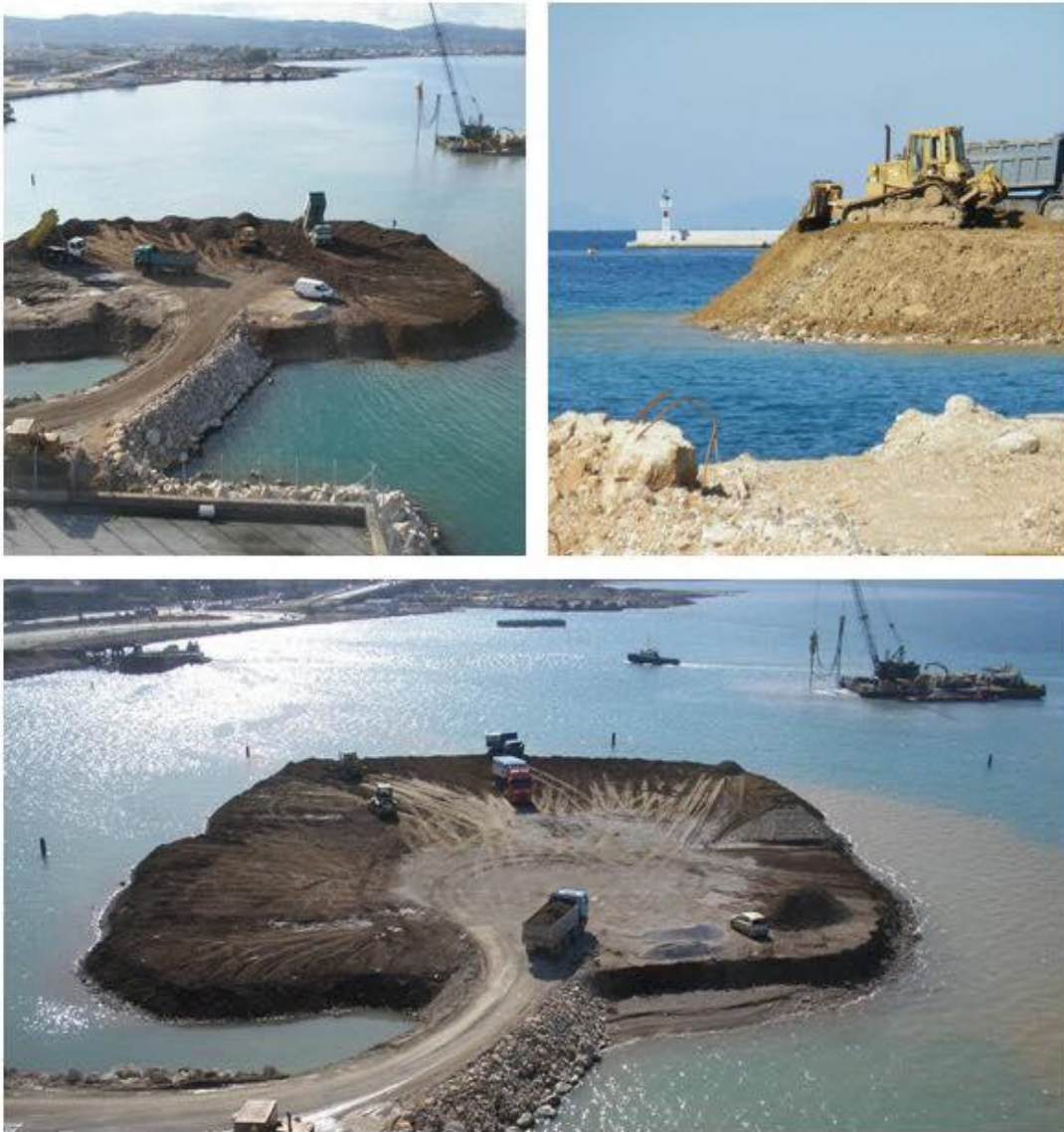
Εικόνα 14 : Εικόνες του έργου κατά την κατασκευή των φάσεων που περιγράφηκαν παραπάνω.
