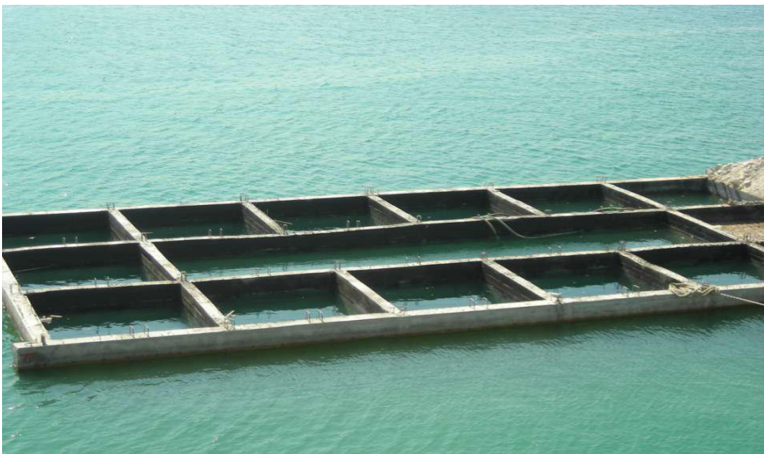
Εικόνα 24 : Οι κυψέλες του caisson. ( www.kgrgroup.gr )
