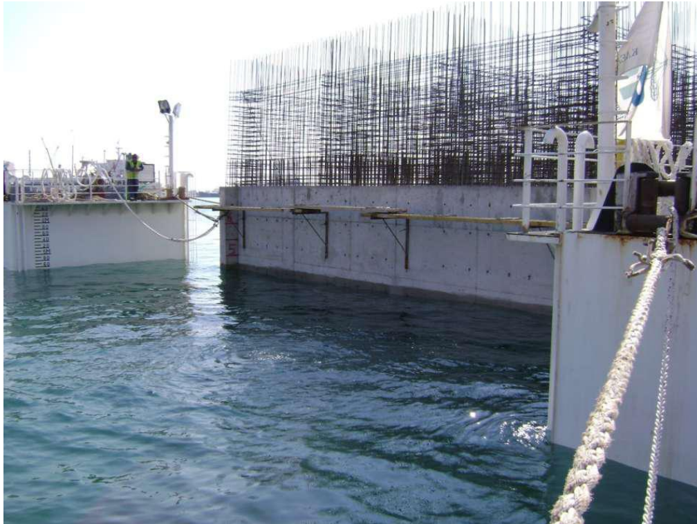
Εικόνα 21 : Η διαδικασία καθέλκυσης του caisson. ( www.kgrgroup.gr )
