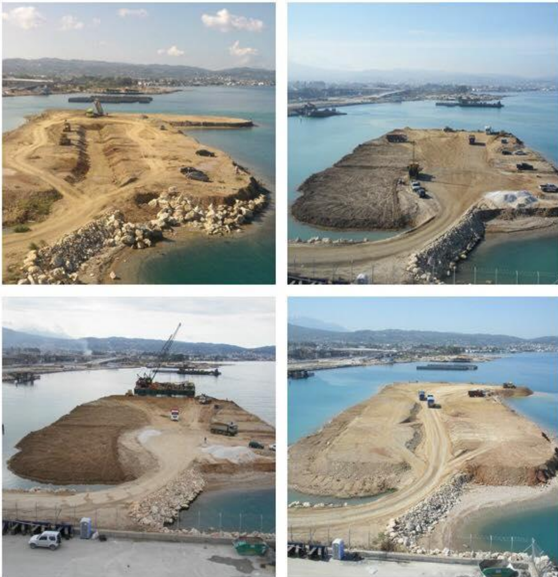
Εικόνα 15 : Το επίχωμα προφόρτισης σε διαφορετικά στάδια κατά την κατασκευή του.
