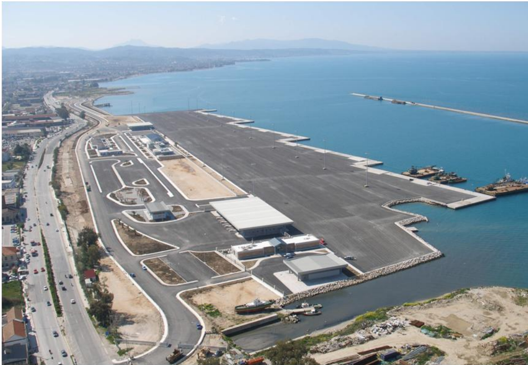
Εικόνα 5 : Ο Νέος Λιμένας Πατρών μετά το πέρας του 2ου τμήματος της Α' φάσης.
