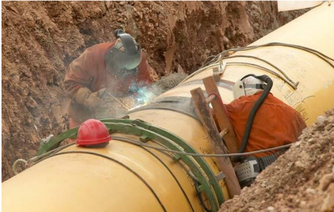
Σχήμα 1.3.6. Διαδικασία συγκόλλησης. Νότια Ουαλία αγωγός φυσικού αερίου. Ο μεγαλύτερος αγωγός φυσικού αερίου του Ηνωμένου Βασιλείου υψηλής πίεσης (317 km) ( www.nationalgrid.com ).
