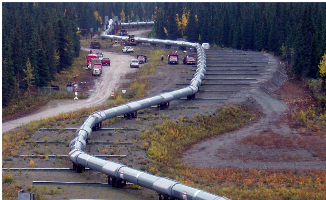
Σχήμα 1.3.1. Ο αγωγός πετρελαίου trans-Αλάσκα, όπου διασχίζει το Denali Fault. Τα ειδικά πέδιλα αφήσει το σωλήνα να κινηθεί πλευρικά 6m και 1.5m κάθετα (Alaska Natural Gas Transportation Projects).
