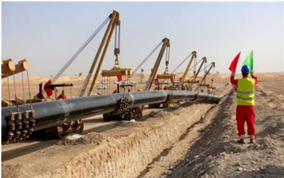
Σχήμα 1.3.5. Τοποθέτηση 170 km αγωγού πετρελαίου στα Ηνωμένα Εμιράτα ( www.pipelinesinternational.com ).
