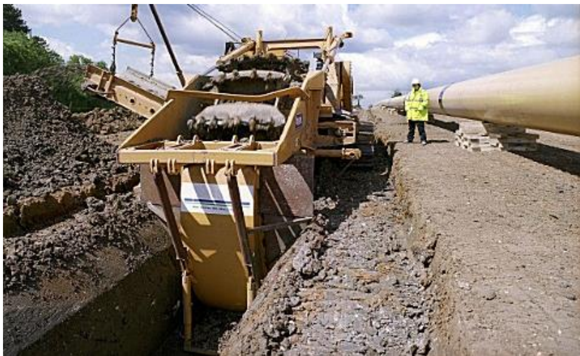
Σχήμα 1.3.3. Εκσκαφή ορύγματος με χρήση ειδικών μηχανημάτων (Lincolnshire gas pipeline works, United Kingdom).
