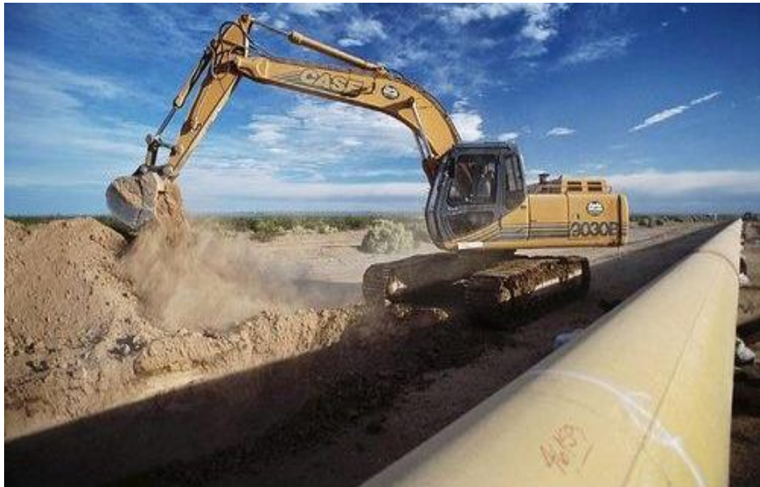
Σχήμα 1.3.2. Εκσκαφή ορύγματος ( www.constructionphotography.com ).
