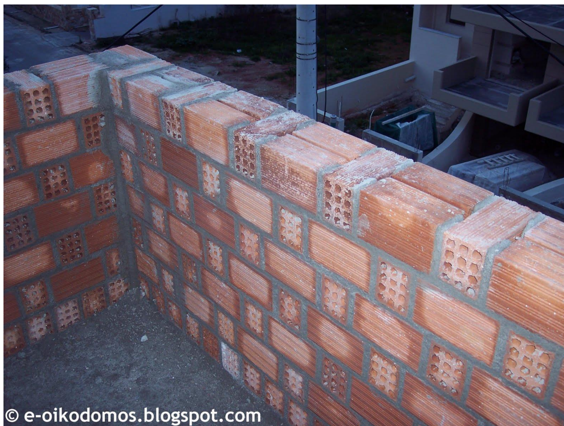
Εικόνα 1.9: Εφαρμογή τουβλοδομής
