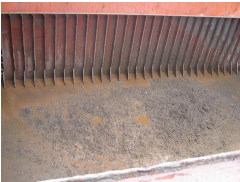
Εικόνα 2. Χώρος αμπαριού μετά από εκφόρτωση σιδηρομεταλλεύματος
