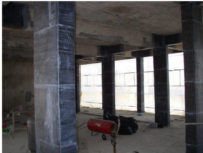
Εικόνα 4.28. Ενίσχυση υποστυλωμάτων με ινοπλισμένα πολυμερή (FRP)
