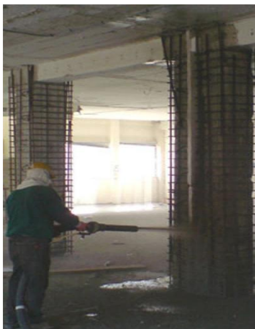
Εικόνα 4.11.Εφαρμογή της μεθόδου εκτοξευόμενου σκυροδέματος
