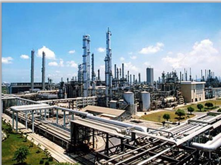
Σχήμα 2-05: Μονάδα επεξεργασίας Φυσικού Αερίου (Πηγή: www.volcanic-heater.com/natural-gas-processing-market.php ) [8]
