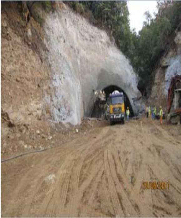
Όψη στομίου εισόδου (προς Τίρανα) βόρειου κλάδου σήραγγας
