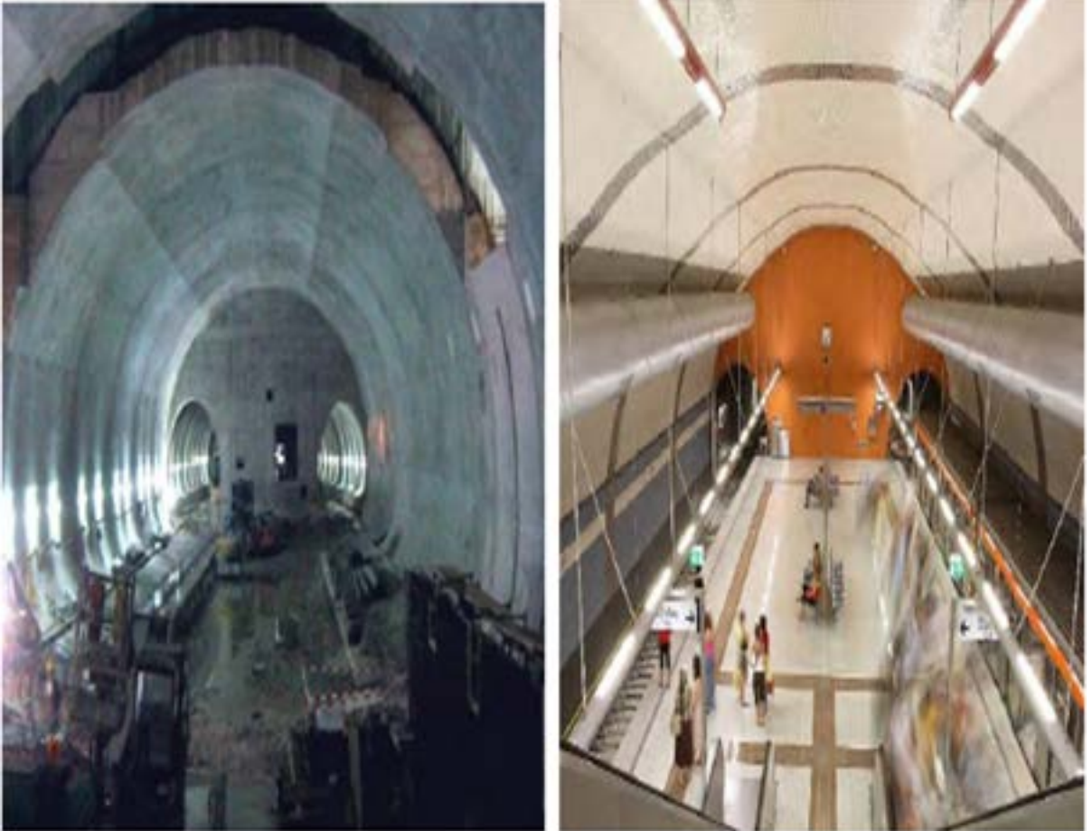
Σχήμα 6: Άποψη του υπόγειου θαλάμου μετά την ολοκλήρωση των σκυροδετήσεων (αριστερά) και μετά την ολοκλήρωση των αρχιτεκτονικών τελειωμάτων (δεξιά).
