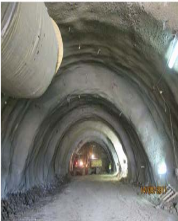
Υπόγειο τμήμα σήραγγας
