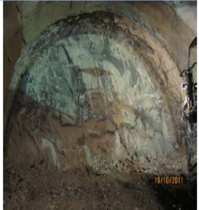
Υπόγειο μέτωπο σήραγγας
