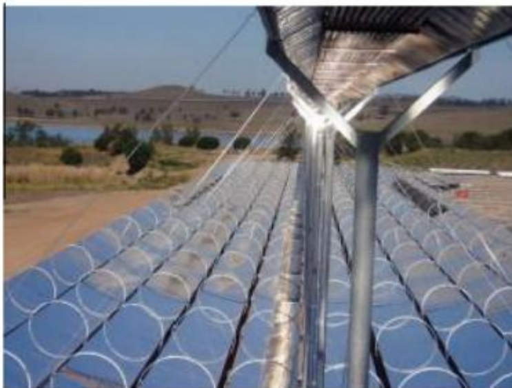
Εικόνα 4.13: Συμπαγής συλλέκτης Fresnel στη μονάδα παραγωγής Kimberlina στην Καλιφόρνια
