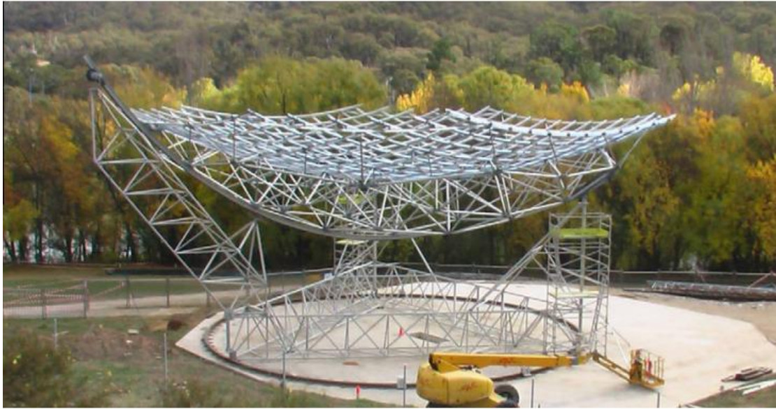
Εικόνα 5.10 : Τοποθέτηση πλαισίων στη βάση με ειδικά μηχανήματα
