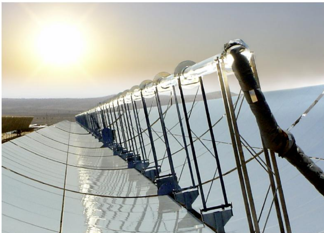
Εικόνα 2.1: Παραβολικό Κοίλο Σύστημα
