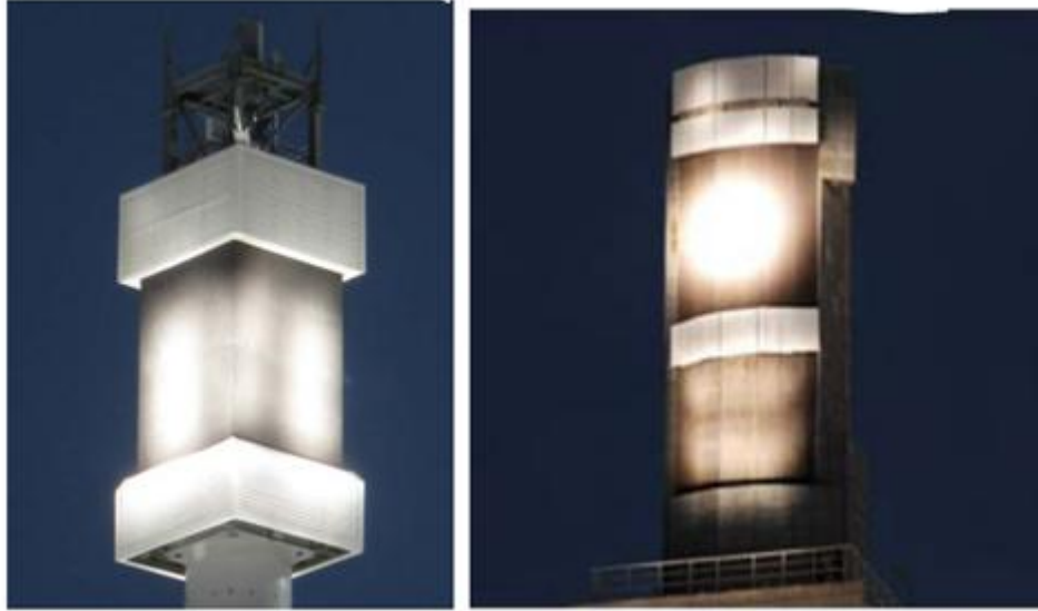
Εικόνα 3.18: Παραδείγματα δεκτών άμεσου ατμού
