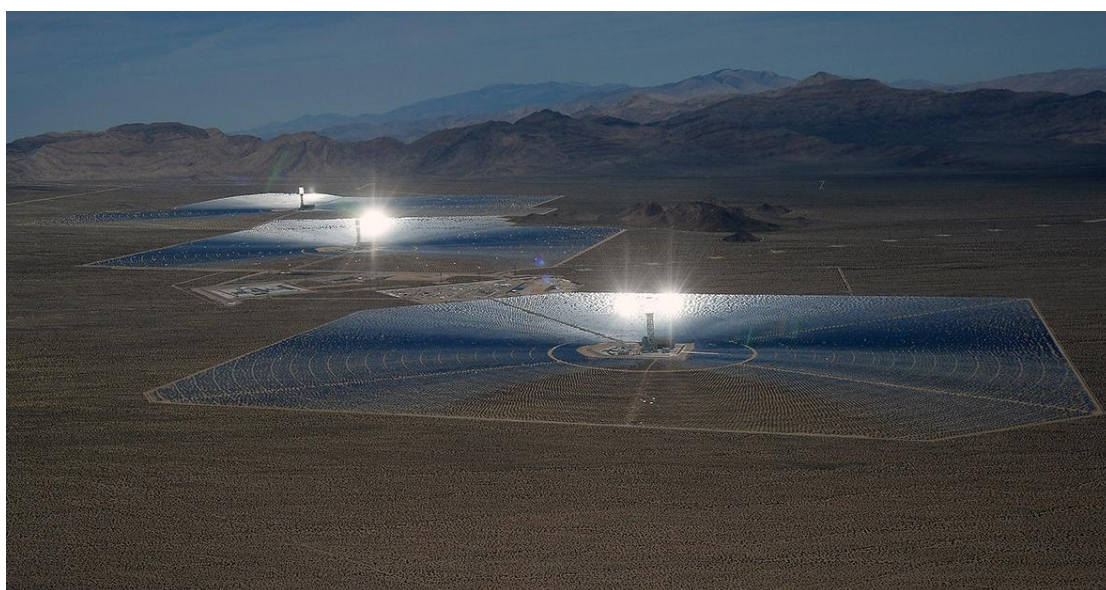
Εικόνα 6.3: Ivanpah Solar Electric Generating System
