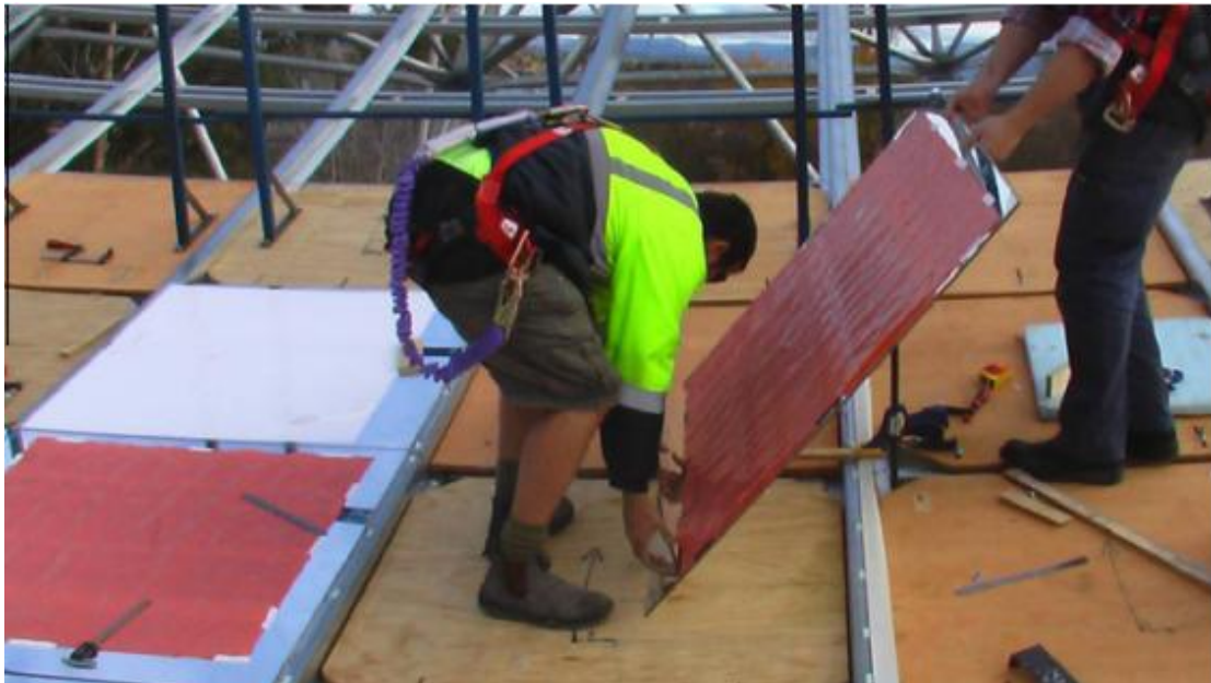
Εικόνα 5.8: Πρώιμο στάδιο εγκατάστασης ενός καθρέπτη στην επιφάνεια
