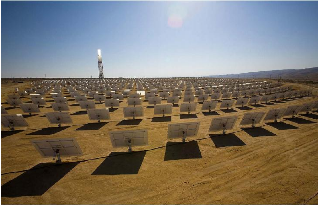
Εικόνα 3.2: Ηλιακός Πύργος Ισχύος και πεδίο των ηλιοστατών
