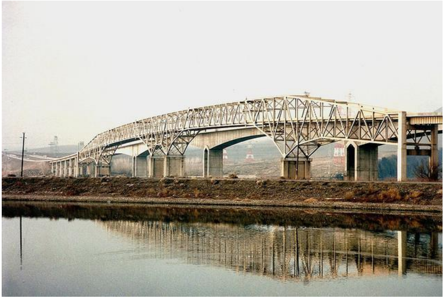
4.18 Χαλύβδινη γέφυρα Columbia river bridge, Umatilla, Oregon, USA
