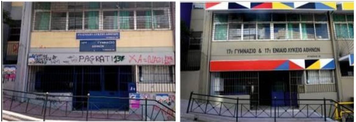
17ο Γυμνάσιο – Λύκειο στο Μετσ, πριν και μετά – πηγή: http://www.cityofathens.gr/node/27041
