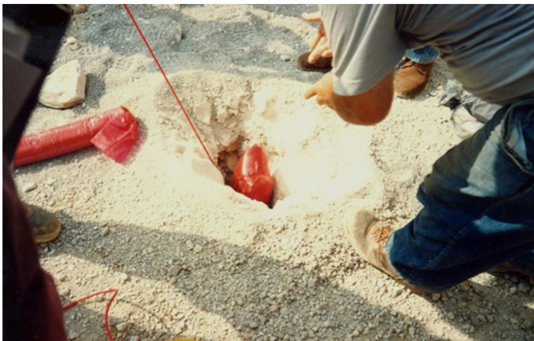
Εικόνα 3. Εργασία γόμωσης διατρήματος με εκρηκτικές ύλες
