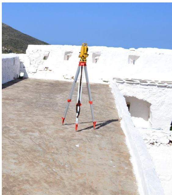
Εικόνα 3.14: Γεωδαιτικός σταθμός στη στάση Σ4.2
