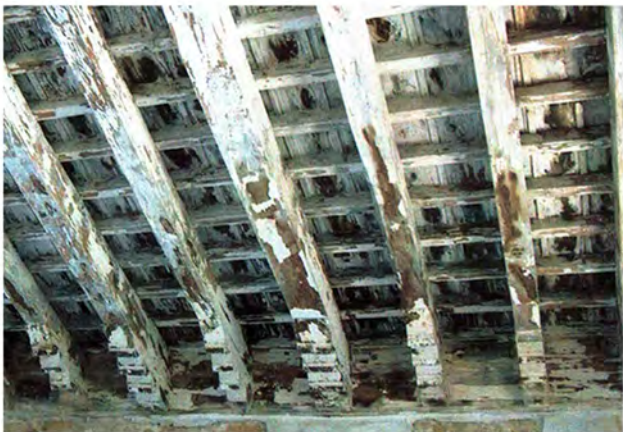
1. Ταβάνι με εμφανή τα δοκάρια του πατώματος και ξύλινα φουρούσια στο κτήριο της Αλεξανδριδου
