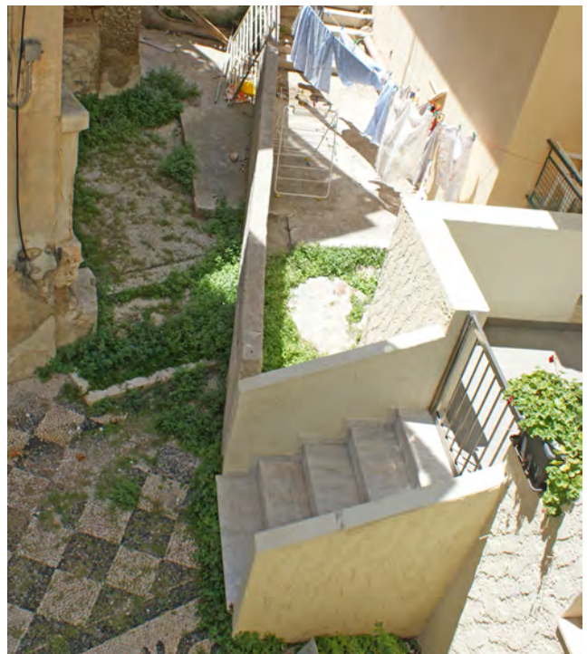
89. 90. Βοτσαλωτό δάπεδο στο χώρο της γωνιακής απότμησης του κτηρίου
