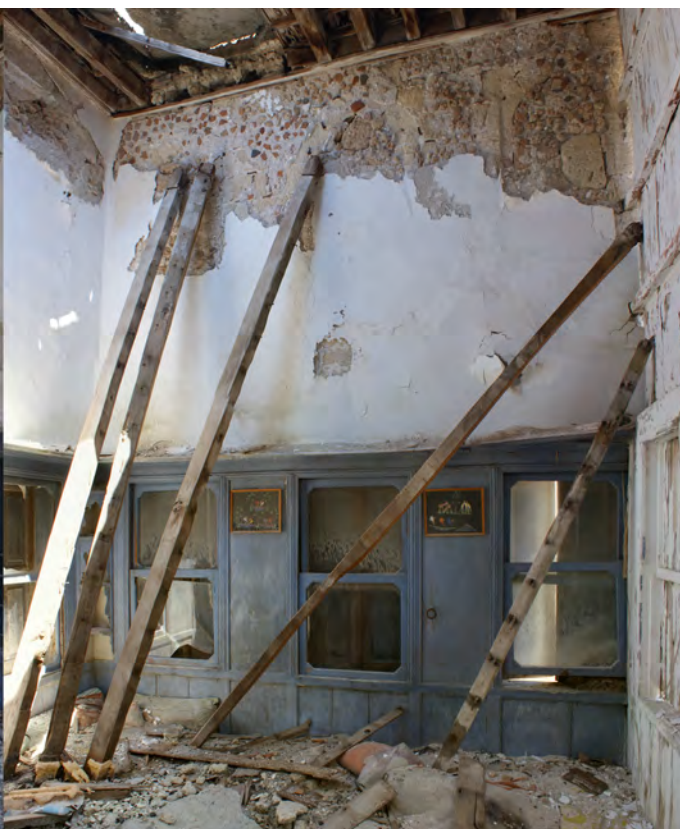
118. ανατολική εσωτερική όψη δωματίου A1.2 (δεξιά φαίνονται οι κογχες του ξυλόπηκτου τοίχου)
