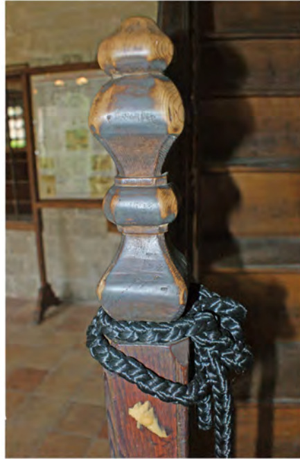
2. Κεφαλοκόλωνα κιγκλιδώματος κλίμακας
