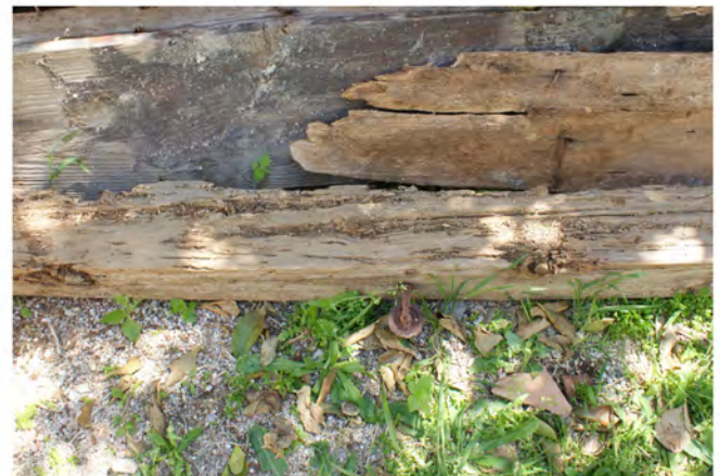
4. Σιδερένιο εξάρτημα ενσωματωμένο σε δοκό, που βρέθηκε στο πρόσκτισμα
