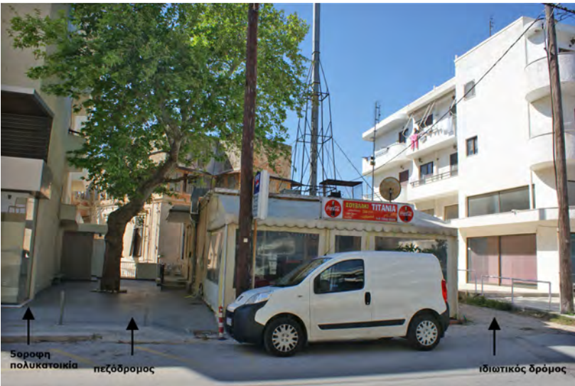
75. Προσβάσεις στο κτήριο από την οδό Κολοκοτρώνη
