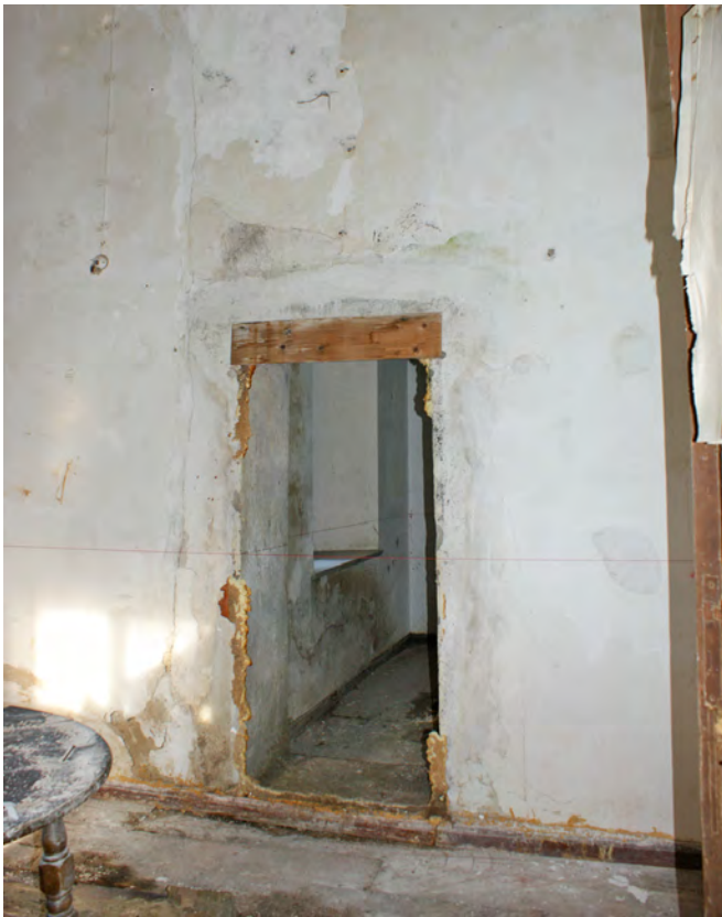
105. Θύρα στον μεσότοιχο για την πρόσβαση στο δωμάτιο Α 0.2
