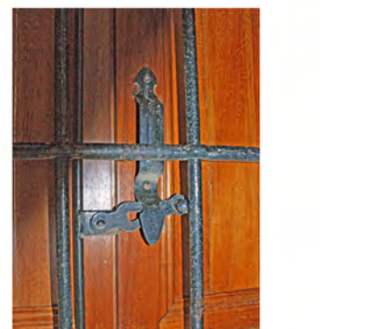
8. Στερέωση σκούρων με σιδερένια στοιχεία
