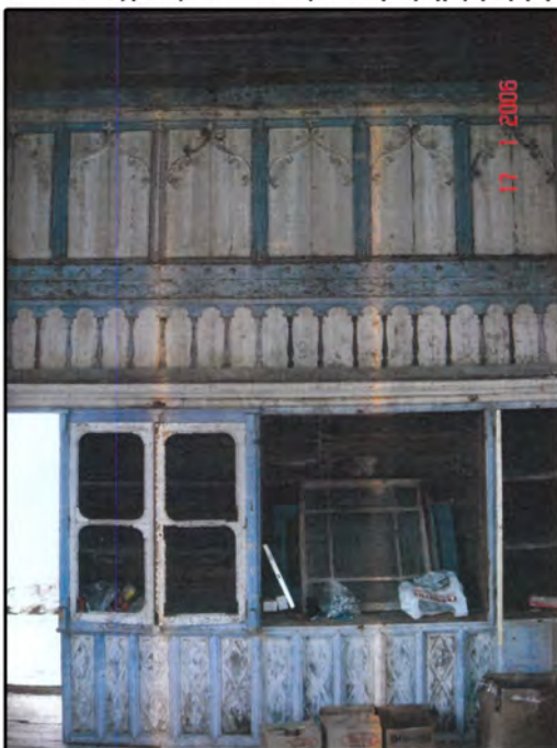
7. Μουσάντρα στο κτήριο της Ομήρου με είσοδο στον οντά μέσα από αυτήν
