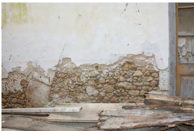
96. Δυτική όψη δωματίου A0.1
