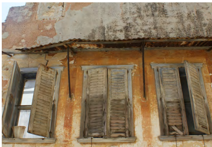
152. Οριζόντια τόξα στα ανώφλια παραθύρων ορόφου
