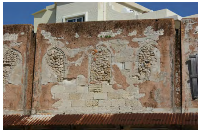
178. Φεγγίτες ορόφου δυτικής όψης
