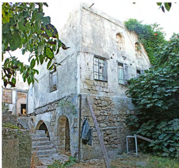
6. Άποψη του κτηρίου από την αυλή
