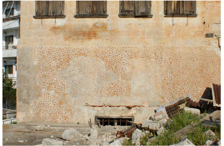
108. ίχνη τοιχισμένων θυρίδων άνω μέρους ισογείου
