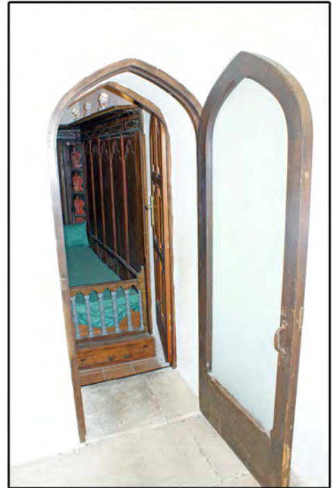
16. Πρόσβαση στο χαμάμ με δύο θύρες στο πάχος του τοίχου
