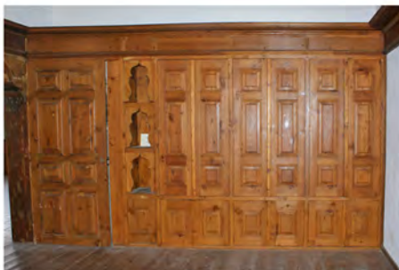
9. Μουσάντρα (κτήριο Ιεροκλέους) με τσατμαδότοιχο στο ανώτερο τμήμα
