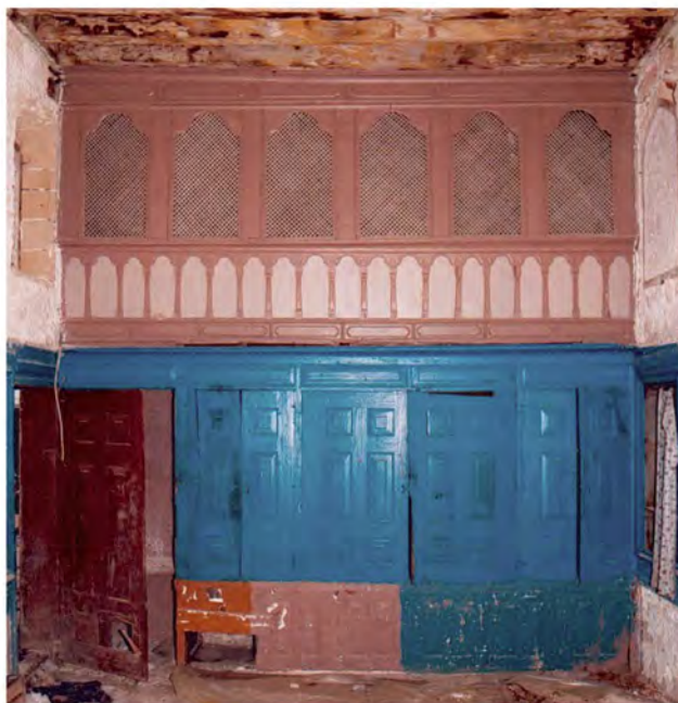
1. Μονή μουσάντρα (οικία Αγ.Φανουρίου & Θουκυδίδου) με τριμερή διάρθρωση και ενσωματωμένη τη θύρα του οντά. Τοίχος στην πίσω πλευρά
