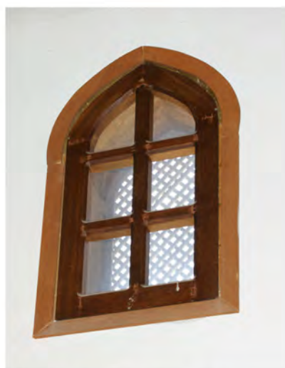
18. Νέωτερος φεγγίτης με κατακόρυφο και οριζόντια καίτια
