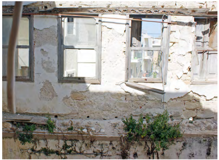
167. Πίσω από την κορνίζα ταβανιού διακρίνεται ξυλοδεσιάπατώματος
