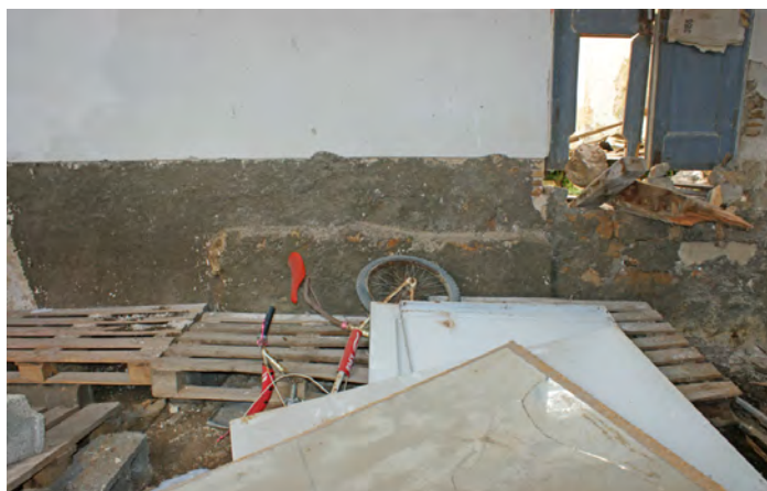
155. Τοιχοποιία με πατούρα για την έδραση των δοκών του πατώματος
