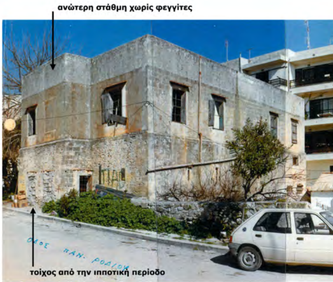
3. Άποψη πριν την αποκατάσταση
