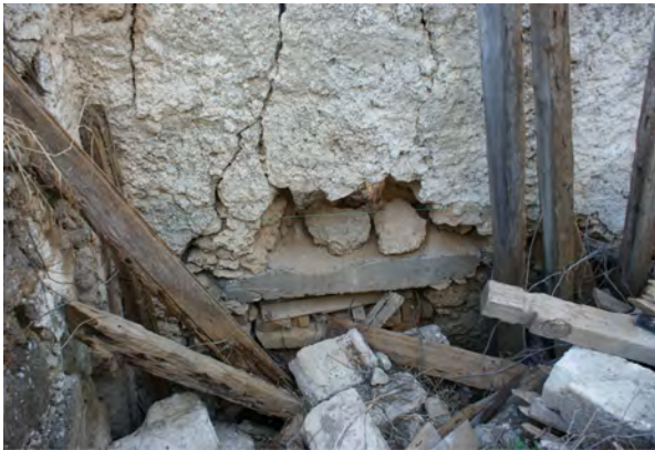
135. Τοιχισμένη διανοιγμένη θύρα στον νότιο τοίχο (αριστερό άνοιγμα)
