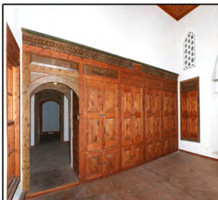
10. Μουσάντρα (κτήριο Ιεροκλέους) με είσοδο στον οντά μέσα από αυτήν
