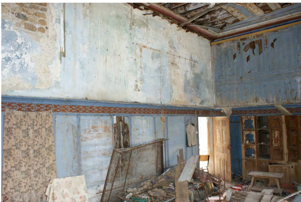
123 Ανατολικός τοίχος οντά με φραγμένα ανοίγματα προς τον σοφά
