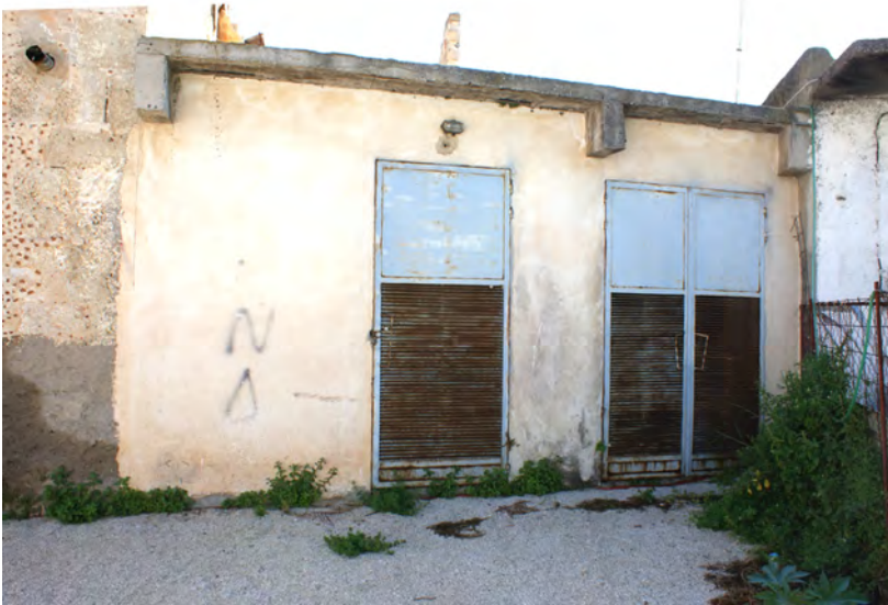
73. Υποσταθμός ΔΕΗ (Δυτική πλευρά οικοπέδου)
