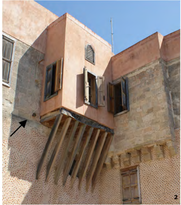
1.2 Σαχνισί Τοπσουύμπαση πριν και μετά την αποκατάσταση
