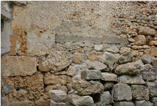
1,2. Ίχνη από τις θύρες στη νότια όψη, που ανοίχθηκαν για την λειτουργία του βυρσοδεψείου (φραγμένες σήμερα)
