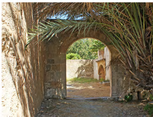
5. Θύρα εισόδου στη ΝΔ αυλή
