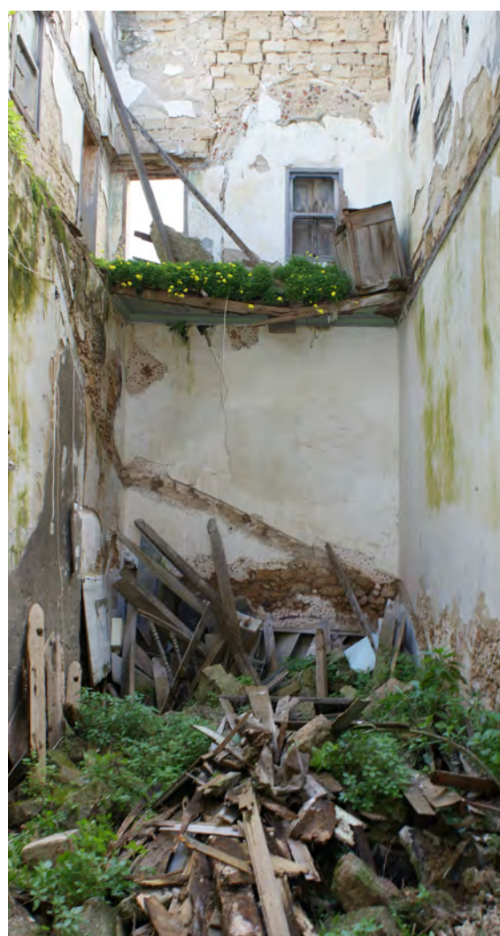
97. Νότια όψη δωματίου A0.1 με ίχνη ξύλινης βαθμιδοφόρουστον τοίχο του ισόγειου
