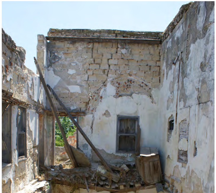
115. Νότια όψη δωματίου A1.1 με οξυκόρυφο τόξο και λαξευμένο βεργίο
