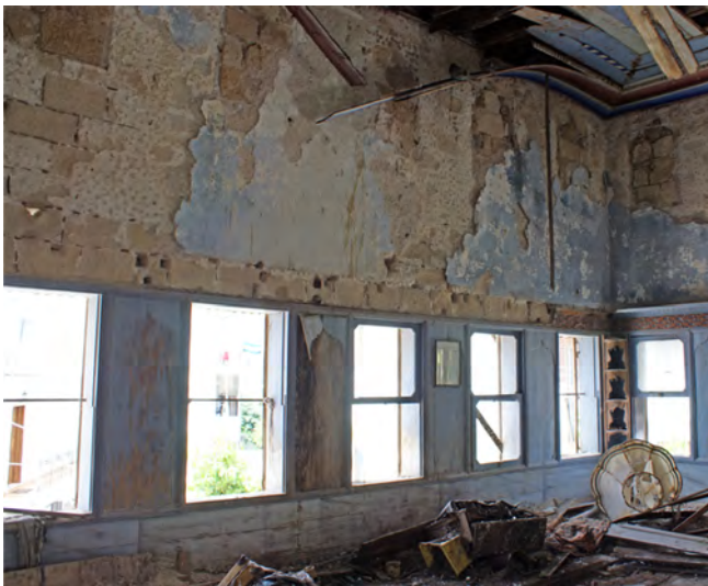
122. Δυτικός τοίχος ανδρικού οντά, άλλοτε καθιστικός χώρος
