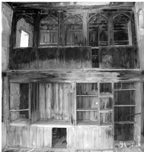
3. Διπλή μουσάντρα (κτήριο Τοπτσούμπαση) με τριμερή διάρθρωση, θύρα οντά ενσωματωμένη, απλή διακόσμηση από την πλευρά του haremlik
