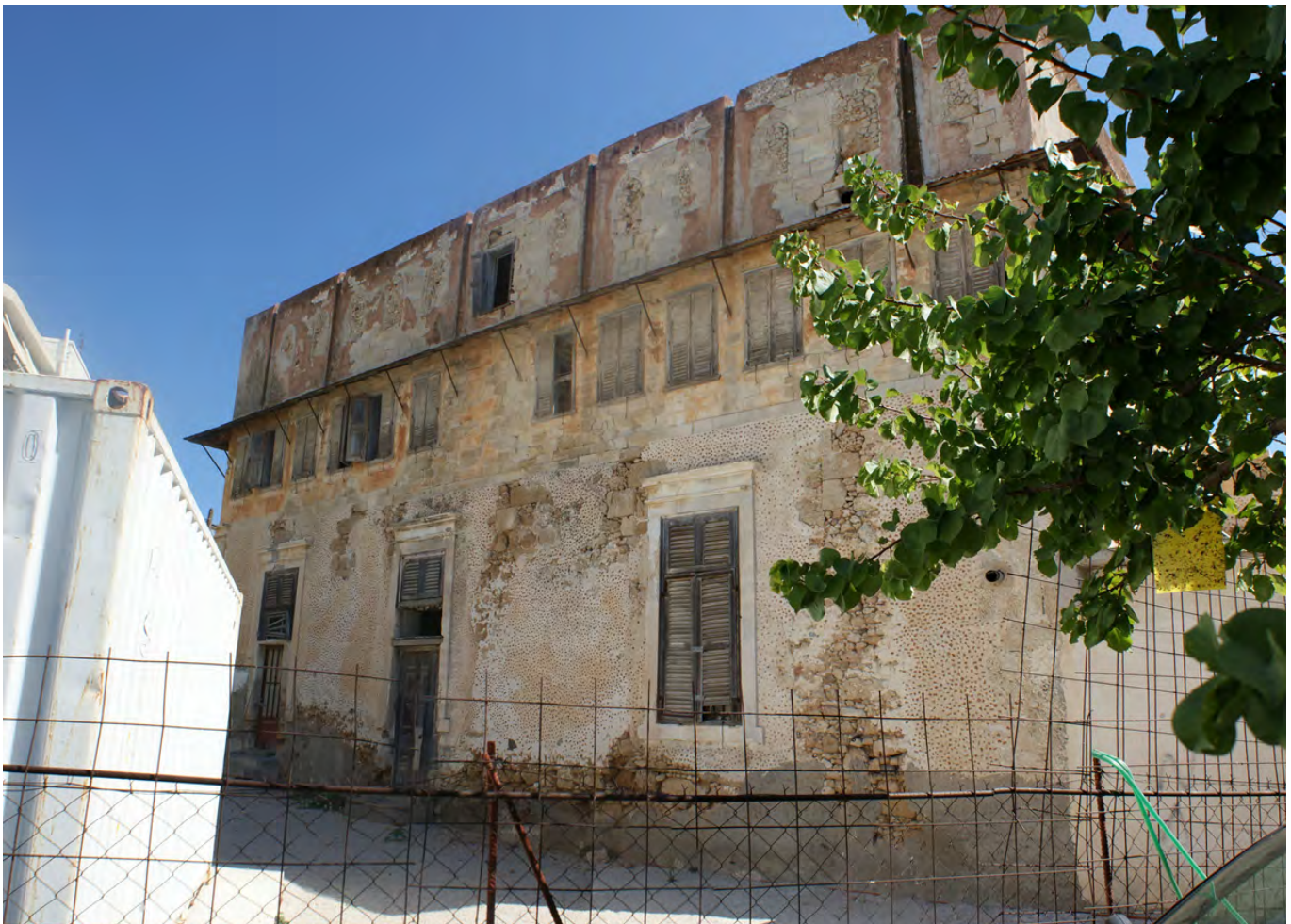
70. Δυτική όψη κυρίως κτίσματος
