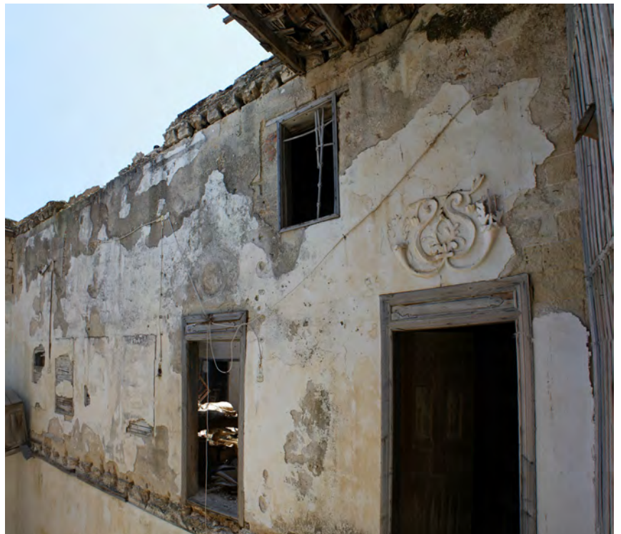
114. Δυτική όψη δωματίου A1.1
