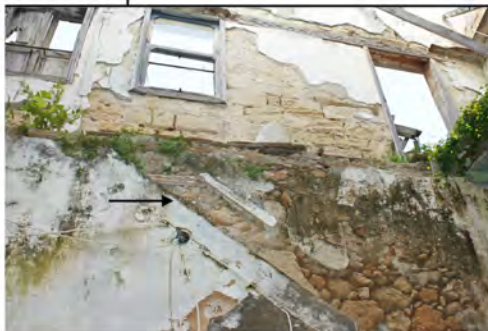
2. Θυρίδα ανατολικής όψης με ξύλινο πρέκι και λίθινους λαμπάδες
