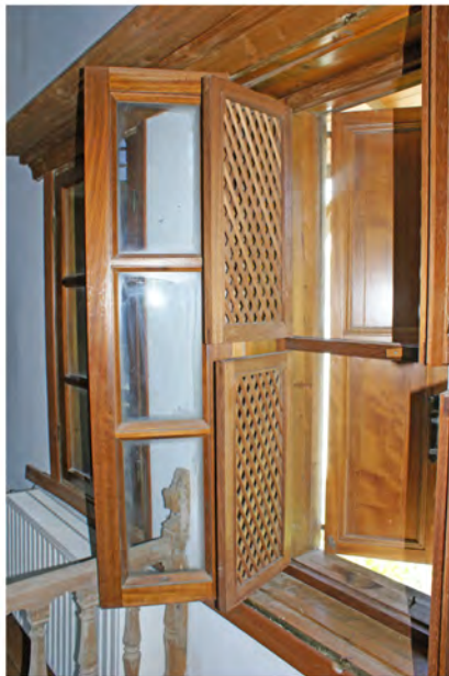
2. παράθυρο με καφασωτό σε δύο τμήματα στο ενδιάμεσο
