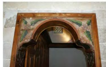
10. Μετά την αποκατάσταση
