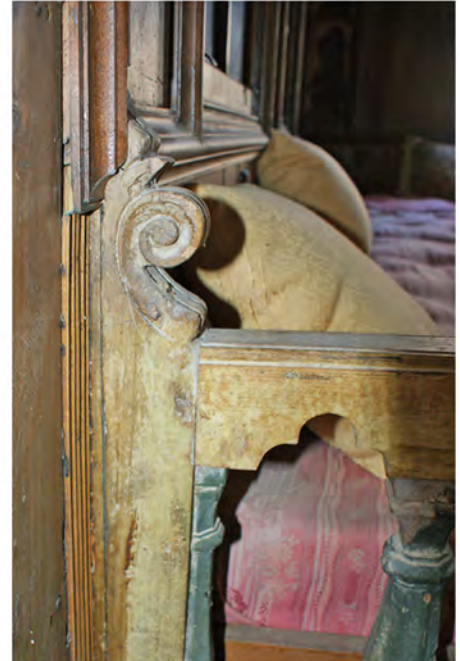
3. Απόληξη κιγκλιδώματος στην πλευρά του τοίχου
