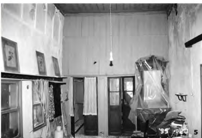
Εικ.5 Δεύτερος ξυλόπηκτος τοίχος στο χαγιάτι και ψευδοφεγγίτες στον εξωτερικό τοίχο
