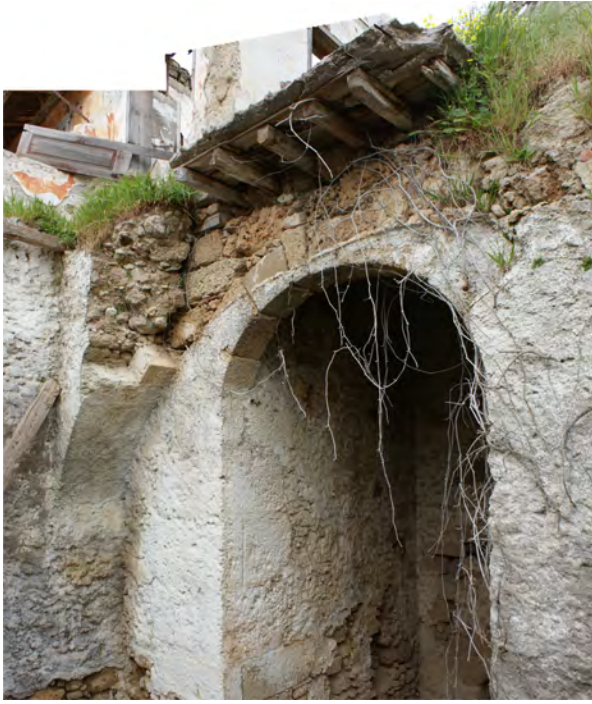
134. Μικρό τόξο γεφύρωσης τοίχων και υπολείμματα από το δεύτερο και μεγαλύτερο τόξο
