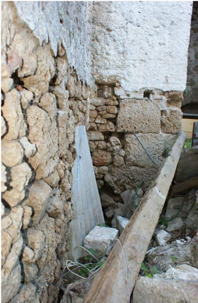
3. Δοκοθήκες από τον ξύλινο σκελετό, που υπήρχε κατά την περίοδο της Ιταλικής κατοχής
