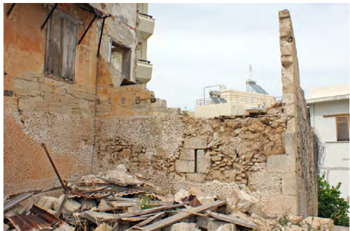
138. Τοιχισμένη διανοιγμένη θύρα στον νότιο τοίχο (αριστερό άνοιγμα)
