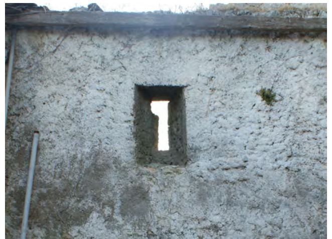
177. Εσωτερική όψη θυρίδας αερισμού στον δυτικό τοίχο του προσκτίσματος
