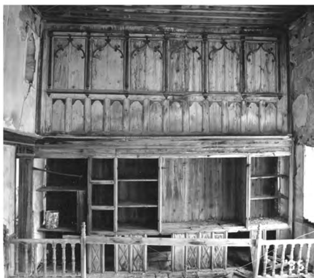
4. Διπλή μουσάντρα (κτήριο Τοπτσούμπαση) με πλουσιότερη διακόσμηση από την πλευρά του selamlık
