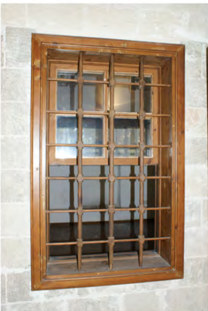
4. Εσωτερικό παράθυρο με ξύλινα κάγκελα προς την πλευρά του χαγιατιού
