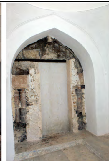
14. Τοίχος με αεραγωγούς
