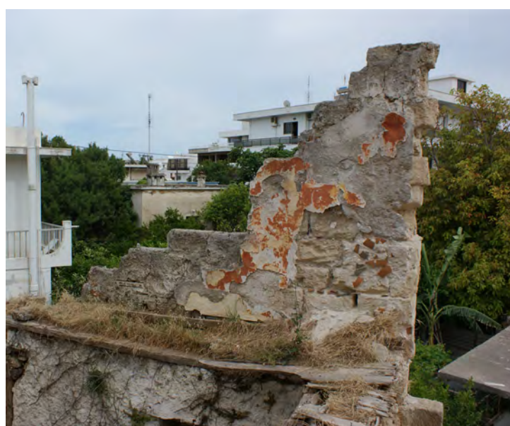
150. Τμήμα ορόφου πρόσκτισματος
