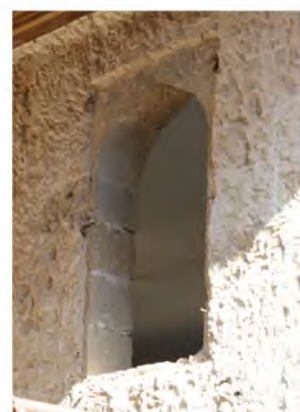
8. Ορθογωνοποίηση εσωτερικής όψης φεγγίτη με λάξευση των λίθων
