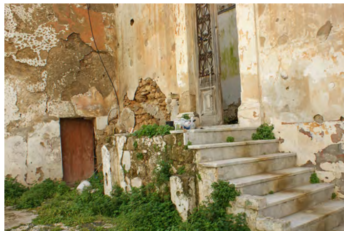
88. Λιθόκτιστη κλίμακα εισόδου στο κτήριο
