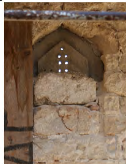
11. Κατασκευή γύψινου φεγγίτη πάνω σε ξύλινο επίπεδο
