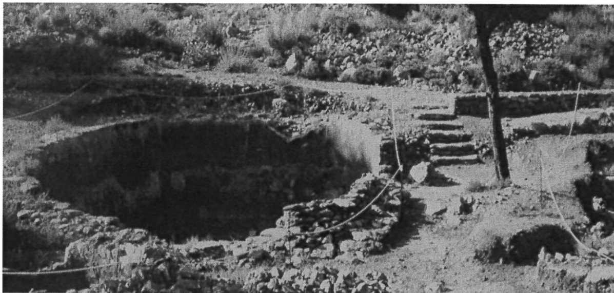
Εικόνα 3.5: Δεξαμενή νερού. Φαίνεται το υδραυλικό κονίαμα
