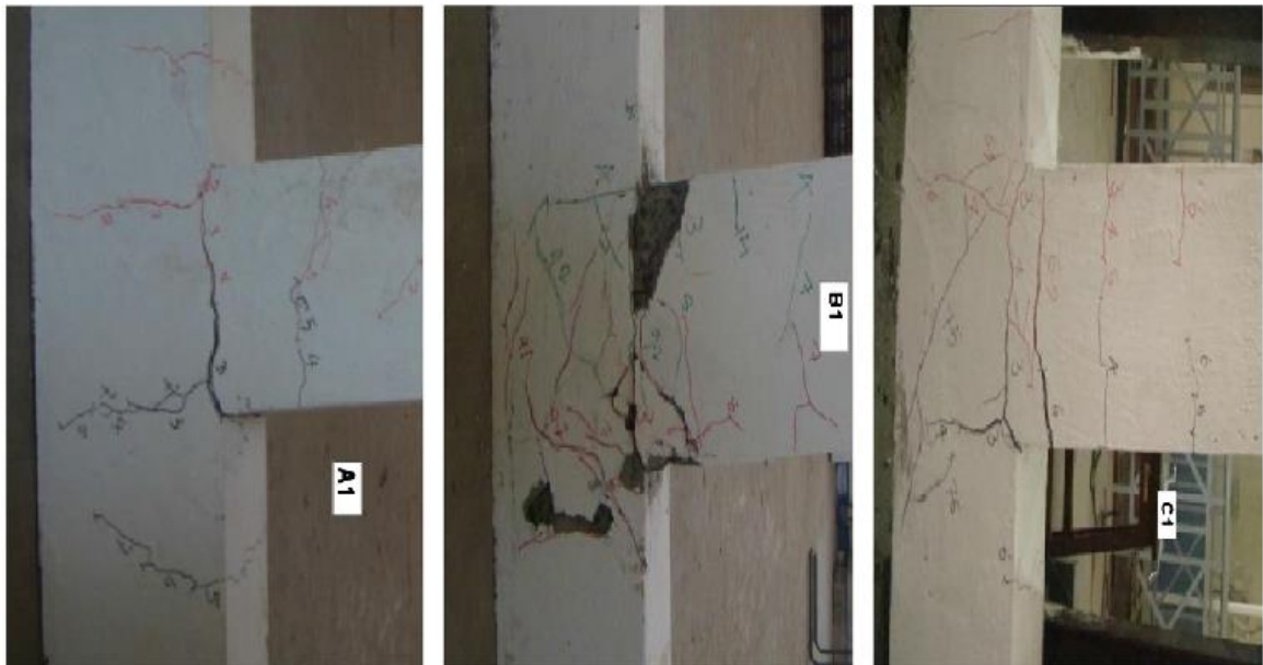
Εικ. 32 Καμπτικές και διατμητικές ρωγμές στα δοκίμια της ομάδας 1 [ 7 ]
