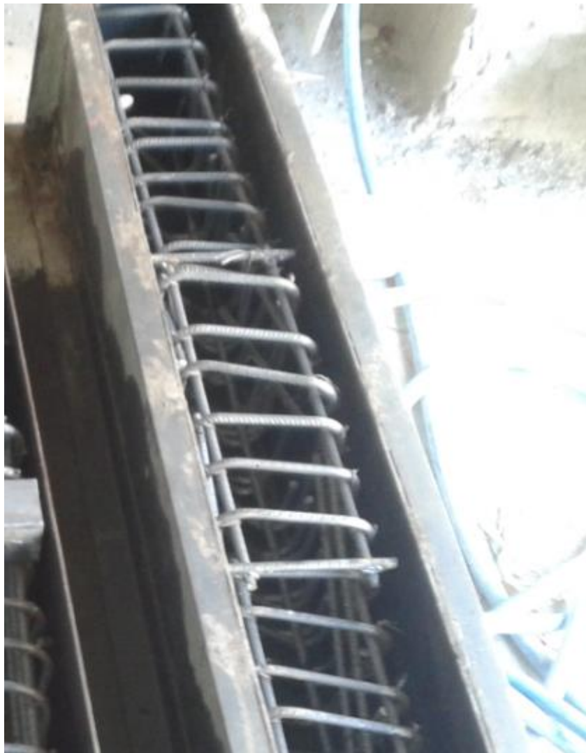
Εικ. 64 Αγκύρωση με εγκάρσια συγκολλημένη ράβδο
