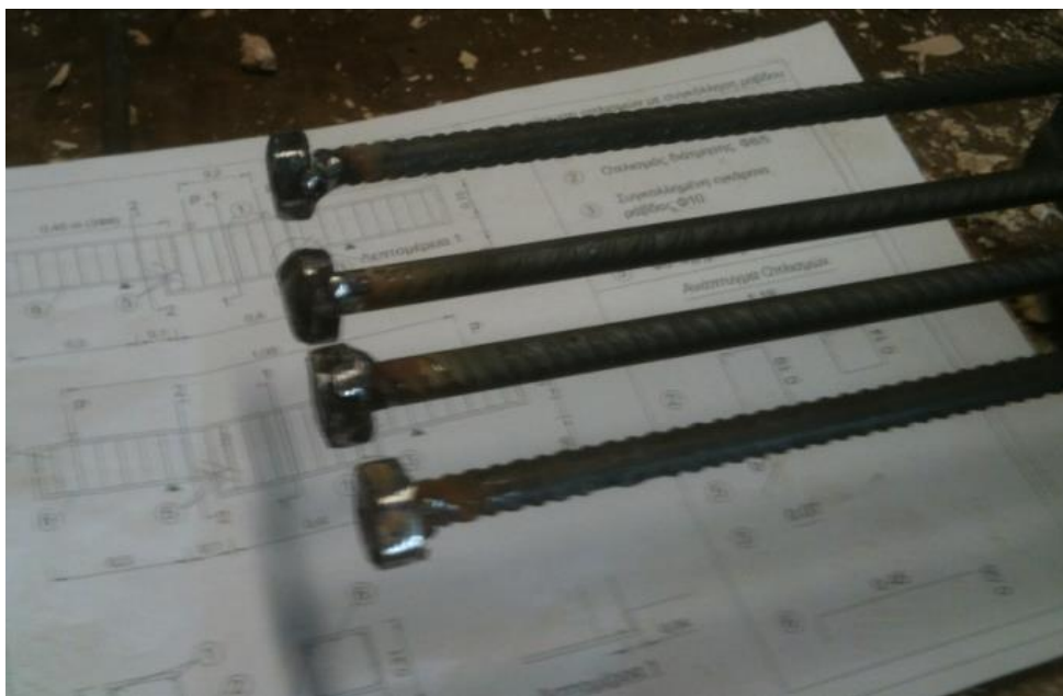
Εικ. 59 Μηχανική αγκύρωση (headed bars)
