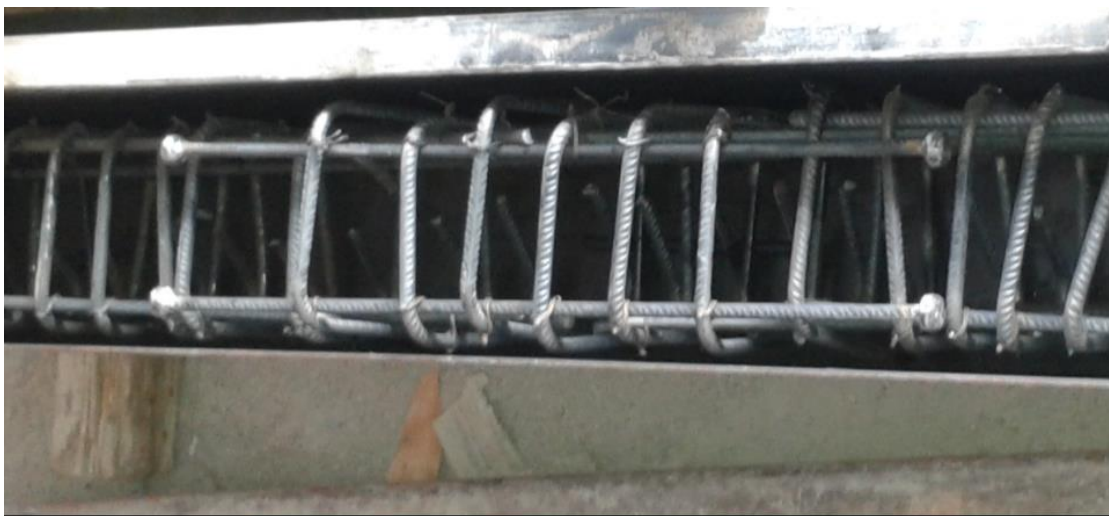
Εικ. 58 Μηχανική αγκύρωση (headed bars)
