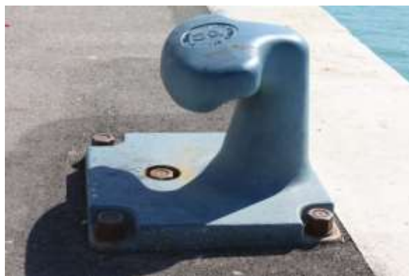
Εικόνα 16: Δέστρα για πλοία στο λιμάνι της Ηγουμενίτσας (Tseneklidis Photography)
