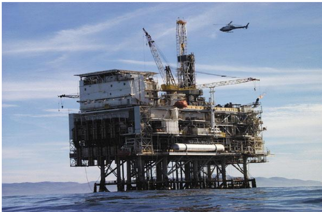
Εικόνα 3.3. Τυπική υπεράκτια πλατφόρμα εξόρυξης αερίου/πετρελαίο
