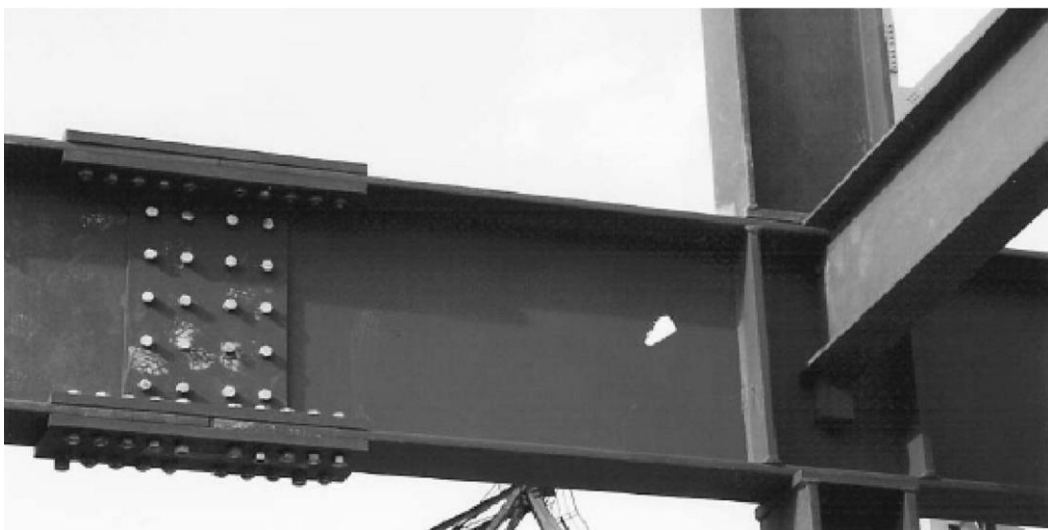
Εικόνα 2.1 : Παράδειγμα σύνδεσης όπου γίνεται χρήση μικρών συγκολλητών προβόλων για τη στήριξη των δοκών
