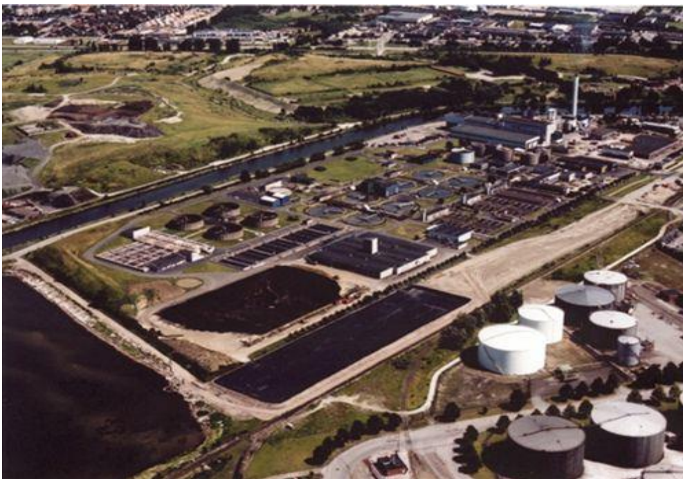
Εικόνα 2.6: Άποψη της Εγκατάστασης Επεξεργασίας Λυμάτων της πόλης Sjölanda στη Σουηδία. Πηγή: Google.
