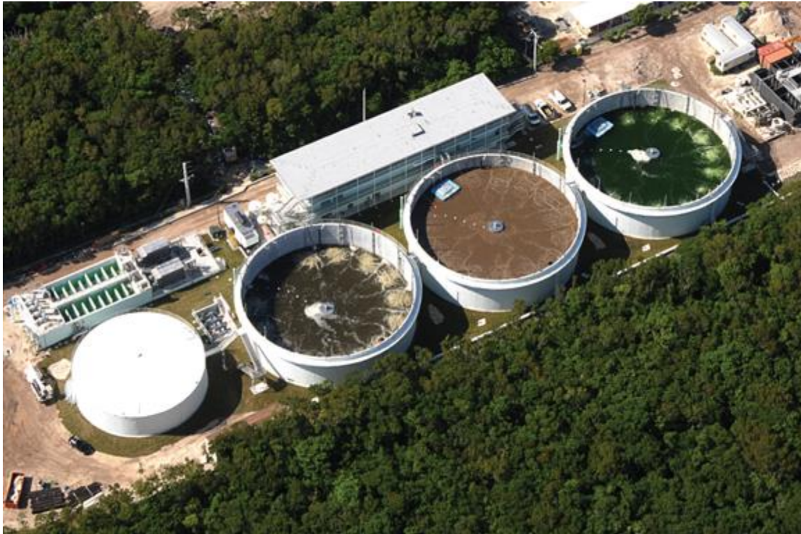
Εικόνα 2.9: Επεξεργασία λυμάτων με αντιδραστήρες SBR στην Ε.Ε.Λ. Key Largo στη Φλόριδα, Πηγή: Google.
