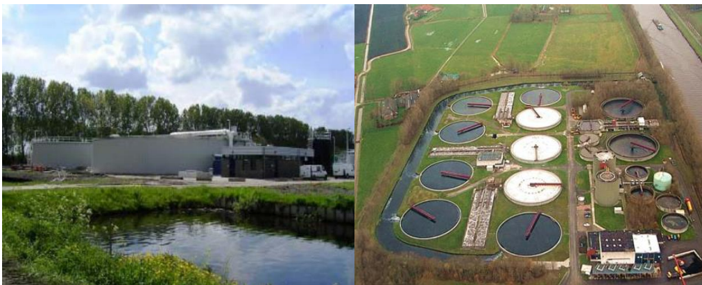
Εικόνα 2.11: Αριστερά άποψη της Εγκατάστασης Επεξεργασίας Λυμάτων (Ε.Ε.Λ.) της πόλης Garmerwolde στην Ολλανδία και δεξιά αντιδραστήρας SHARON στην ίδια εγκατάσταση. Πηγή: van Loosdrecht (2008)
