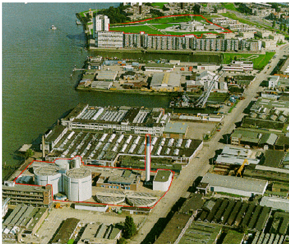
Εικόνα 2.10: Εγκατάσταση επεξεργασίας λυμάτων του Dokhaven στο Ρότερνταμ της Ολλανδίας. Πηγή: van Loosdrecht (2008)
