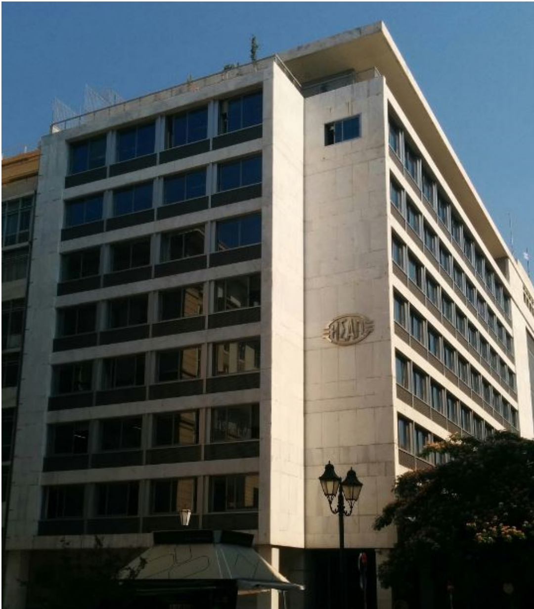
Σχήμα 1.1 Εξωτερική άποψη του υφιστάμενου κτιρίου
