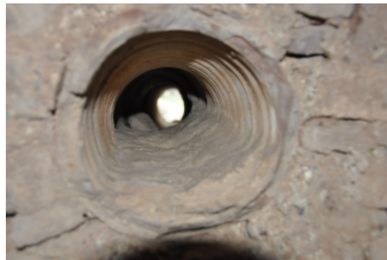
Εικ 25: Πήλινος αγωγός τροφοδοσίας κιστέρνας – Δυτική εσωτερική όψη
