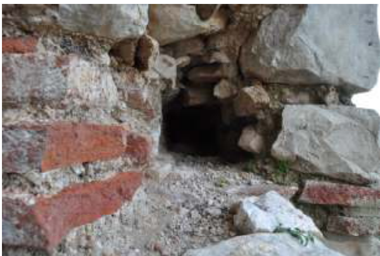
Εικ 35: Οπή μπάρας σύρτη – Βόρειος λαμπάς ανοίγματος εισόδου ορόφου
