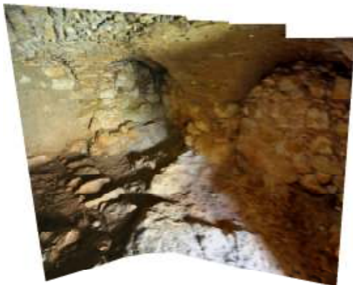
Εικ 47: Εσωτερικό ισόγειου κελιού νότιας πλευράς Πύργου – Νότιος και δυτικός τοίχος
