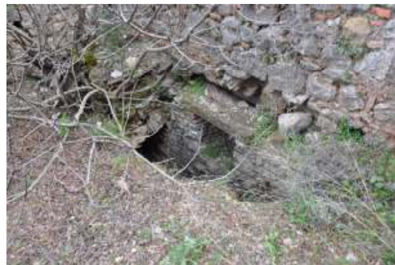
Εικ 21: Κατάρρευση βορείου άκρου θόλου – Λήψη μέσα από όροφο
