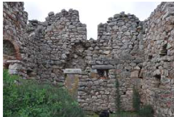
Εικ 31: Νότιος εσωτερικός τοίχος ορόφου
