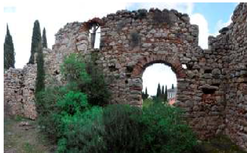
Εικ 33: Ανατολικός εσωτερικός τοίχος ορόφου
