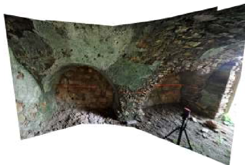
Εικ 49: Εσωτερικό κελιού ορόφου νότιας πλευράς Πύργου – Νότιος τοίχος
