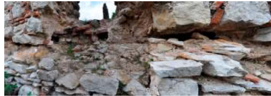
Εικ 38: Ίχνος ξυλοδεσιάς νοτίου ανοίγματος ορόφου
