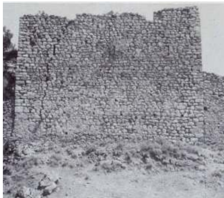
Εικ 52: Ρηγμάτωση δυτικής όψης. Χ. Μπούρας – Η Νέα Μονή της Χίου, Ιστορία και Αρχιτεκτονική (1981)
