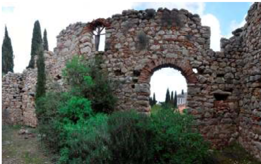
Εικ 30: Ανατολικός εσωτερικός τοίχος ορόφου
