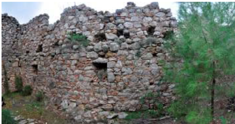
Εικ 29: Δυτικός εσωτερικός τοίχος ορόφου
