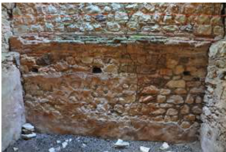
Εικ 24: Βόρεια εσωτερική όψη κιστέρνας
