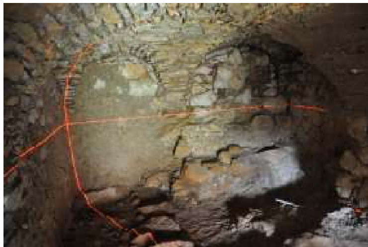
Εικ 48: Εσωτερικό ισόγειου κελιού νότιας πλευράς Πύργου – Δυτικός τοίχος
