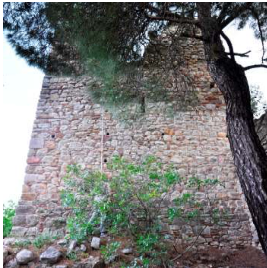
Εικ 16: Βόρεια όψη
