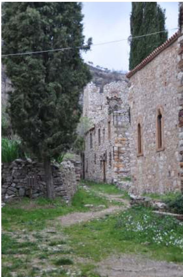
Εικ 3: Θέα του Πύργου από την δυτική πλευρά του καθολικού
