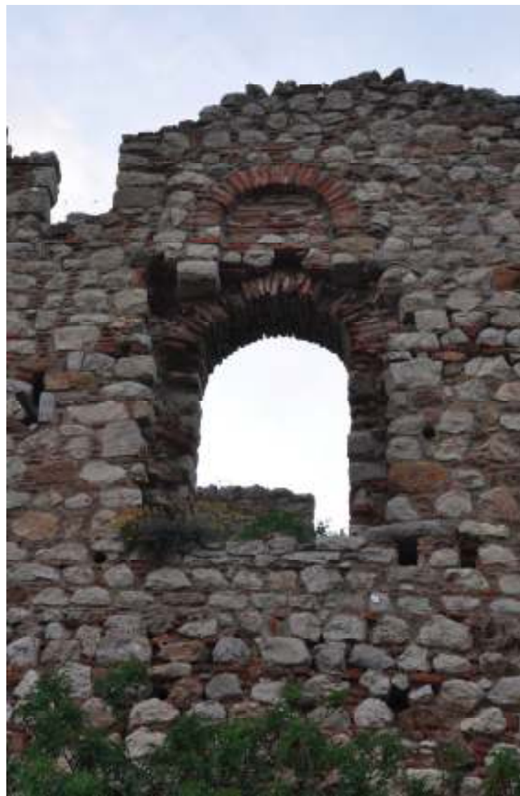
Εικ 36: Ανατολικό άνοιγμα εισόδου ορόφου – Εξωτερική λήψη
