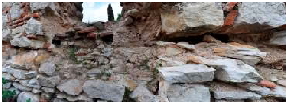
Εικ 43: Οπή ξυλοδεσιάς – Ποδιά νοτίου ανοίγματος εισόδου ορόφου
