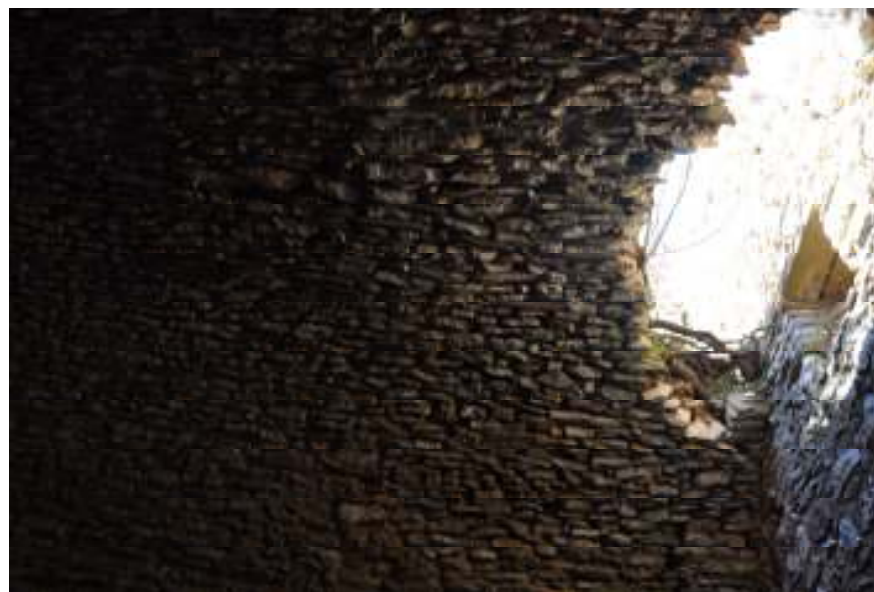
Εικ 53: Κατάρρευση βόρειου άκρου θόλου
