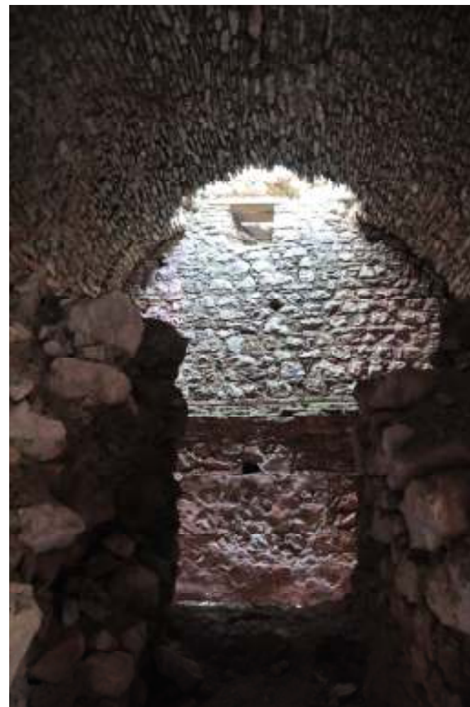
Εικ 29: Ισόγειο – Βόρεια εσωτερική όψη - Κινστέρνα
