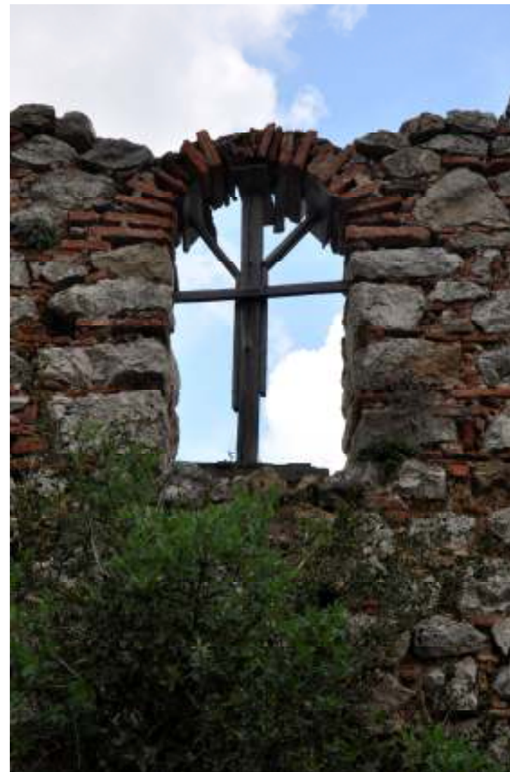
Εικ 44: Παράθυρο μεσοπατώματος ορόφου – Ανατολική εσωτερική όψη
