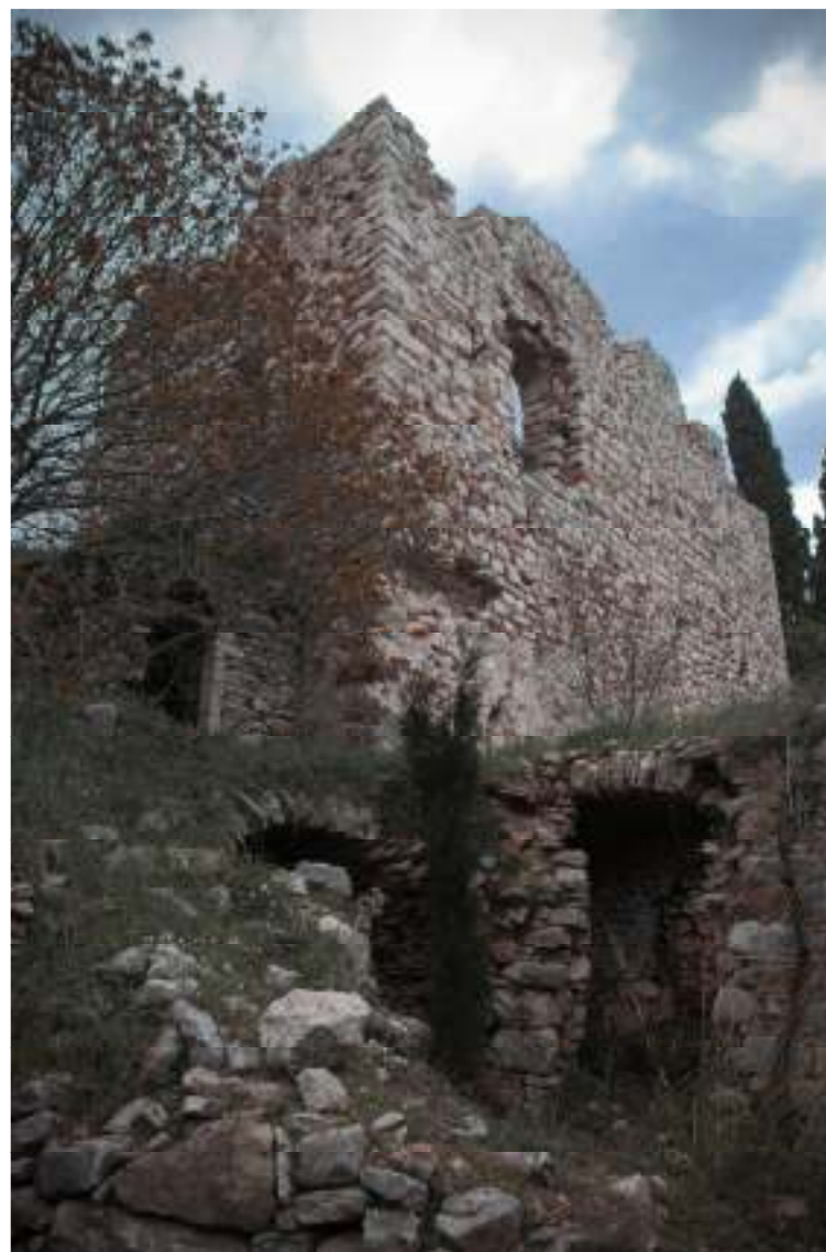
Εικ 9: Νοτιοανατολική εξωτερική λήψη
