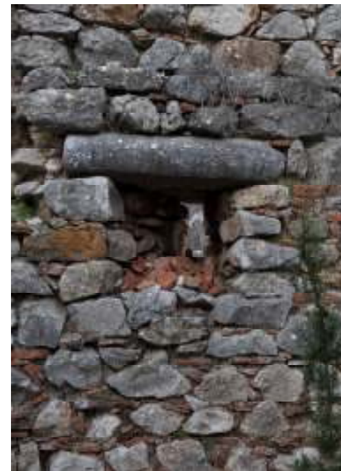
Εικ 37, 38, 39, 40: Τοξοθυρίδες ορόφου
