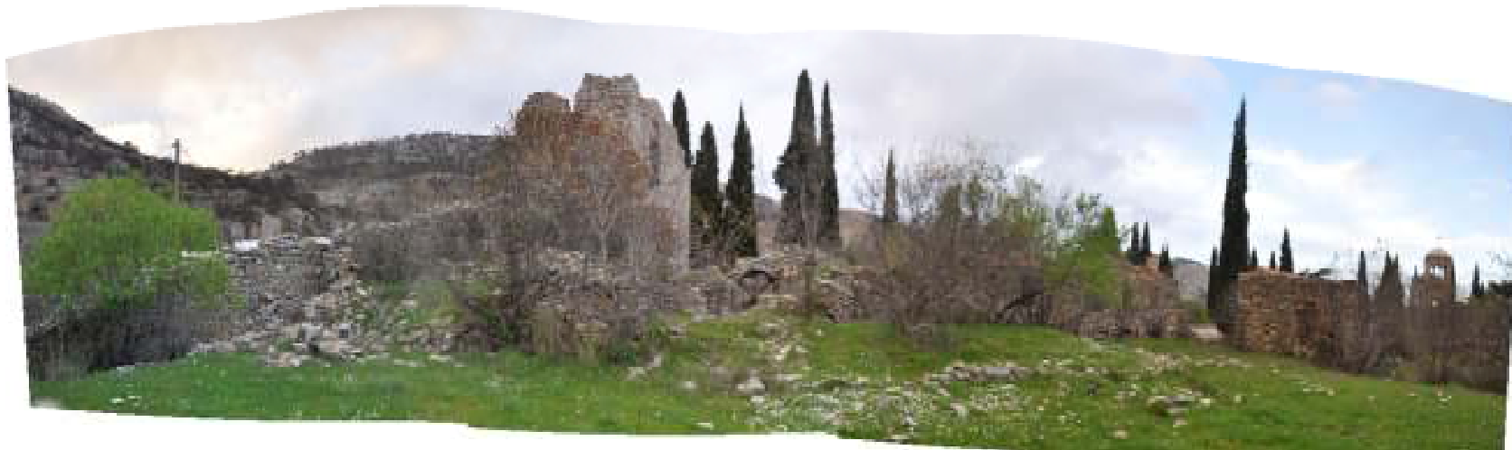
Εικ 7: Λήψη νοτιοανατολικά του πύργου πάνω στο δώμα των κελιών
