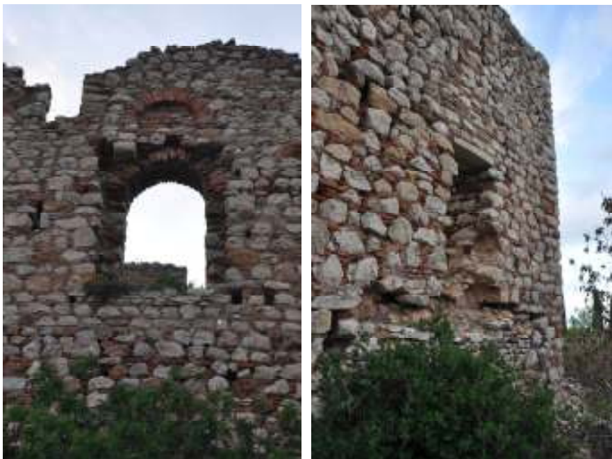
Εικ 34, 35: Ανατολική και Νότια είσοδος ορόφου
