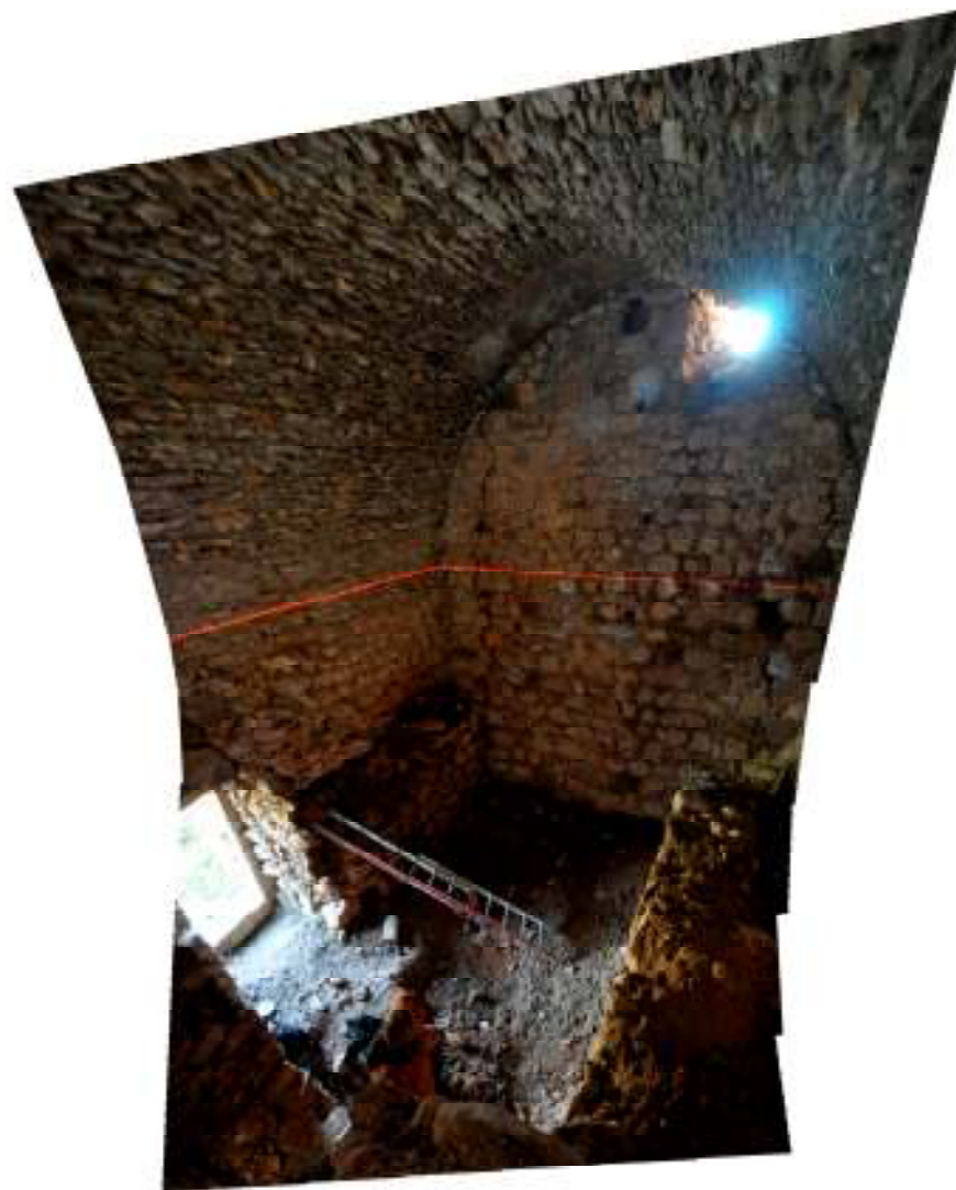
Εικ 19: Νότια εσωτερική όψη ισογείου – Είσοδος
