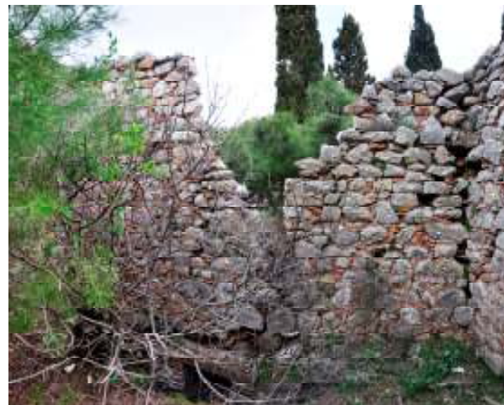
Εικ 32: Βόρειος εσωτερικός τοίχος ορόφου
