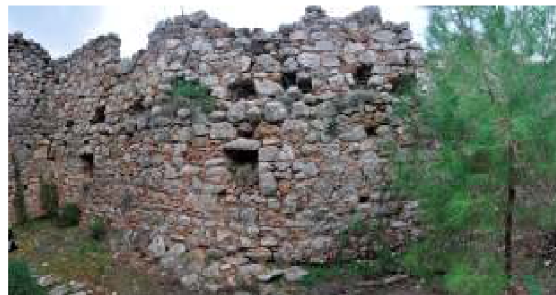
Εικ 32: Δυτικός εσωτερικός τοίχος ορόφου
