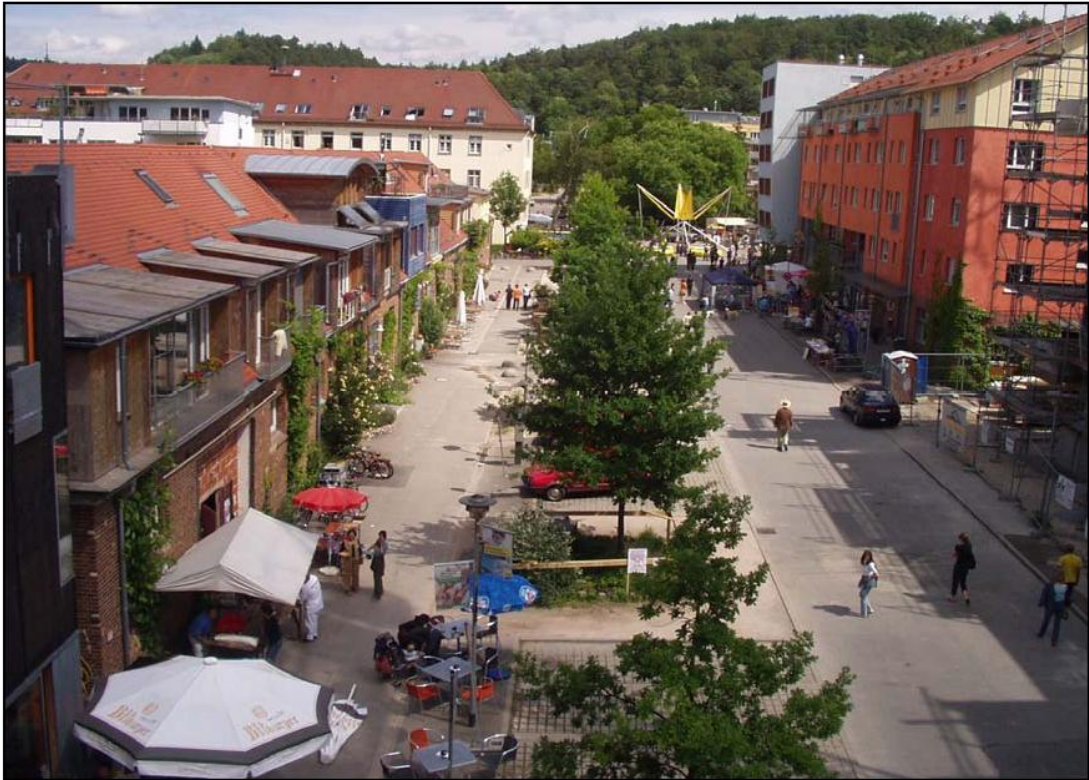
Εικ. 5.23 Η ανάπλαση της περιοχής Franzosisches Viertel/Stuttgarter Straße διαμόρφωσε ένα αστικό περιβάλλον όπου κατοικίες, καταστήματα, εργασία και χώροι πρασίνου συνυπάρχουν σε κοντινές αποστάσεις. Στο βάθος αριστερά διακρίνεται ένα στρατιωτικό κτήριο, στο οποίο σήμερα είναι εγκατεστημένες διάφορες χρήσεις. Πηγή: http://www.tuebingen.de/bilddatenbank/Bild_franzViertel.jpg
