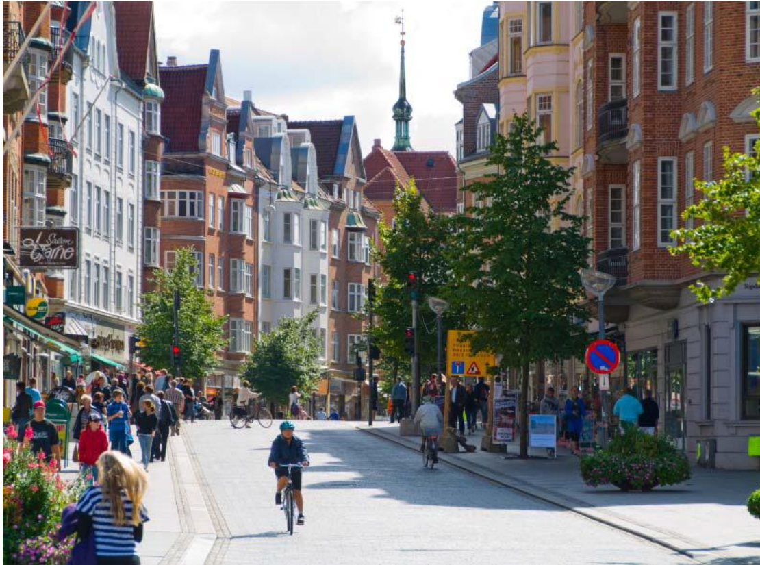
Εικ. 5.25: Διαμόρφωση οδικού χώρου στην περιοχή Osteragade. Η διατομή αναπτύσσεται σε ένα επίπεδο, ενώ ο διαχωρισμός της κίνησης του πεζού από την υπόλοιπη κυκλοφορία γίνεται με την τοποθέτηση κυβόλιθων διαφορετικού χρώματος. Για το ποδήλατο δεν έχει προβλεφθεί ειδική υποδομή, καθώς η κίνηση του εξασφαλίζεται από τη γενικότερη διαμόρφωση της διατομής. Πηγή: http://www.panoramio.com/photo/12263009
