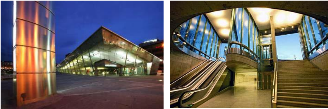
Εικ. 5.3, 5.4: Εικόνες από δύο σταθμούς της νέας σιδηροδρομικής γραμμής.
