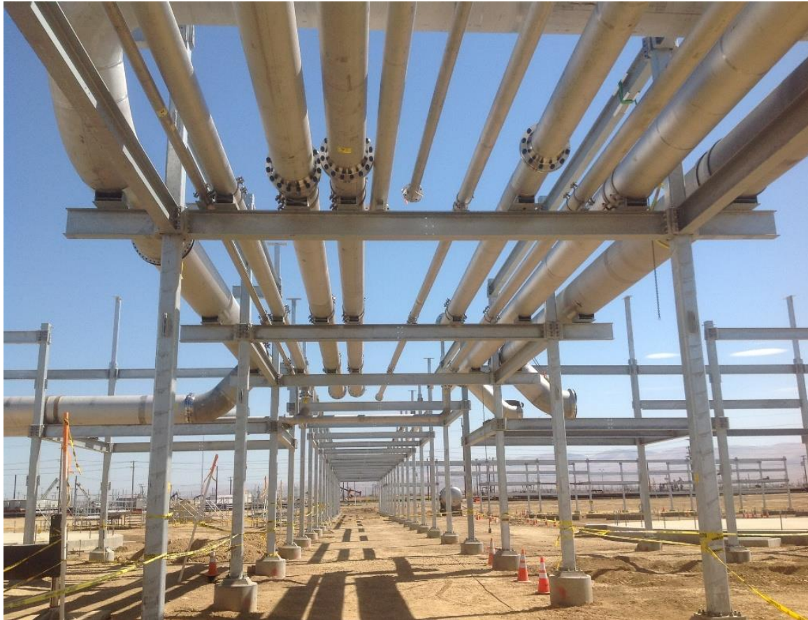
Σχήμα 1-15: Εγκάρσια μεταλλικά πλαίσια σωληνοδιαδρόμων
