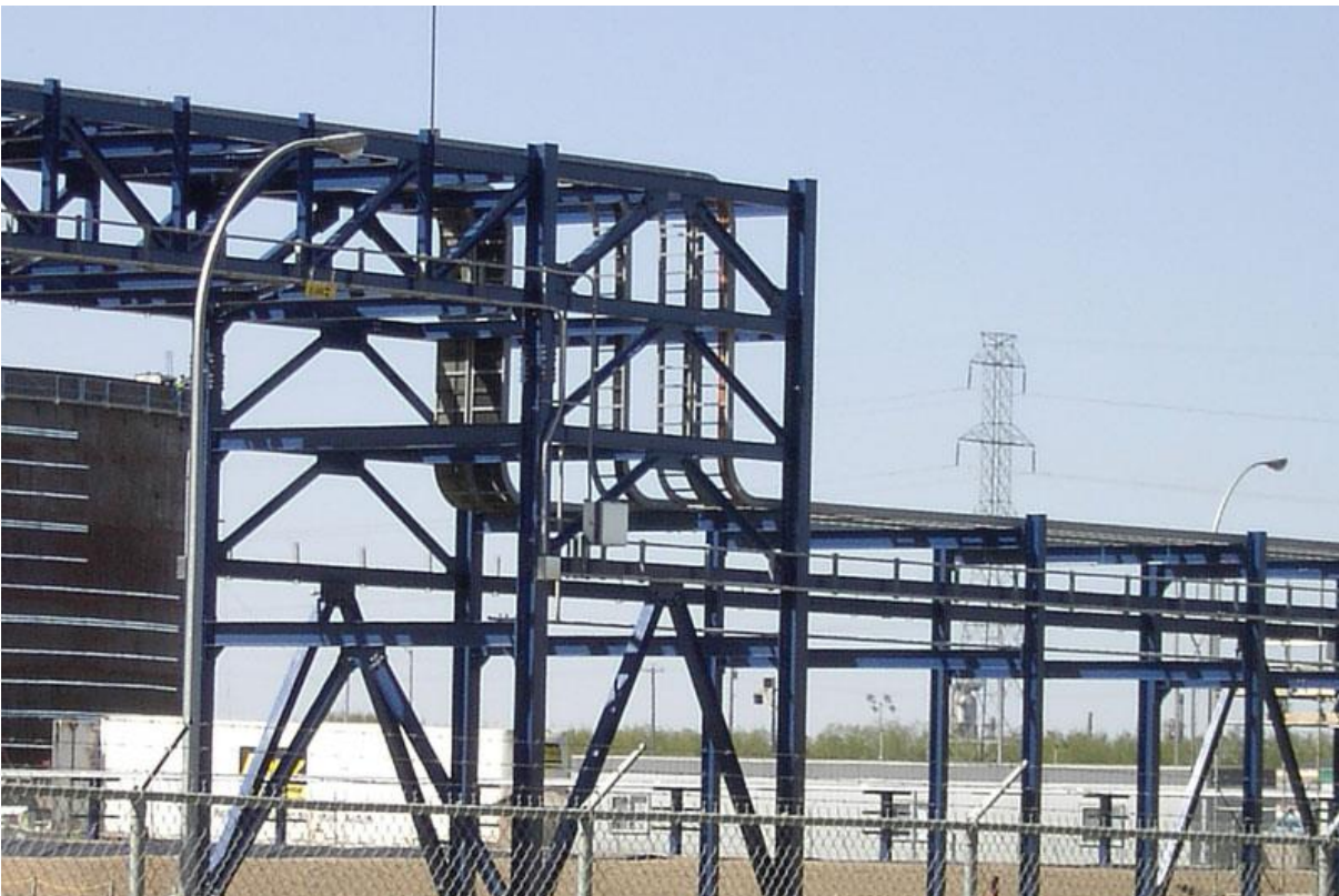
Σχήμα 1-6: Κατασκευή μεταλλικού σωληνοδιαδρόμου [ http://www.safe-harbor.com ]
