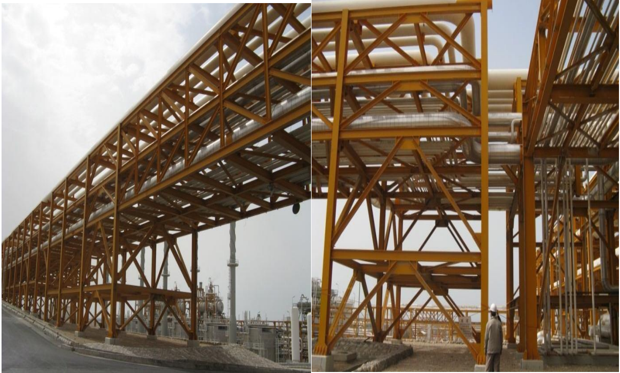
Σχήμα 1-3 : Άμεση εξάρτηση αγωγών με μεταλλικούς σωληνοδιαδρόμους
