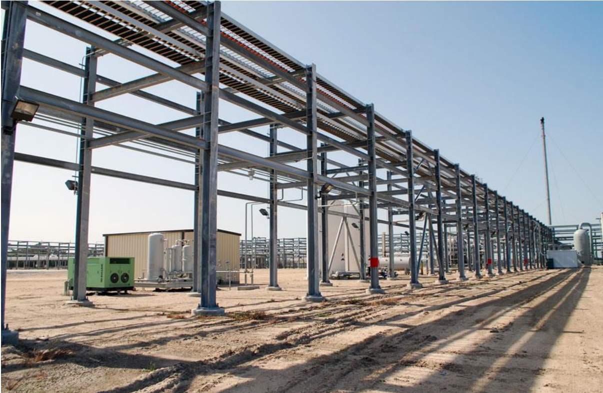
Σχήμα 1-5: Κατασκευή μεταλλικού σωληνοδιαδρόμου [ http://www.csaguirre.com ]
