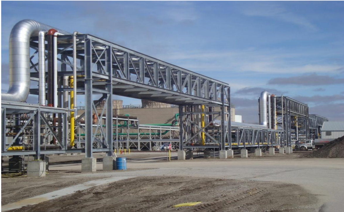
Σχήμα 2-1: Μεταλλικός φορέας σωληνοδιαδρόμου
