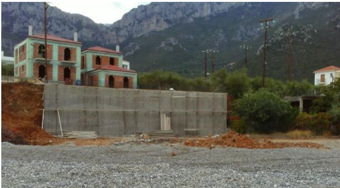
Εικόνα 1.3: Περίπτωση αντιστήριξης όπου ενδεχόμενη αστοχία εγκυμονεί κίνδυνο κατάρρευσης των κτιρίων
