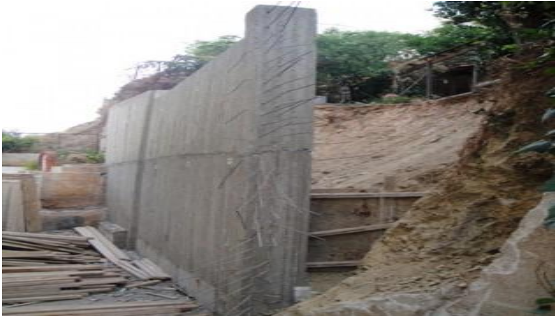
Εικόνα 1.1: Χαρακτηριστική περίπτωση τοίχου αντιστήριξης
