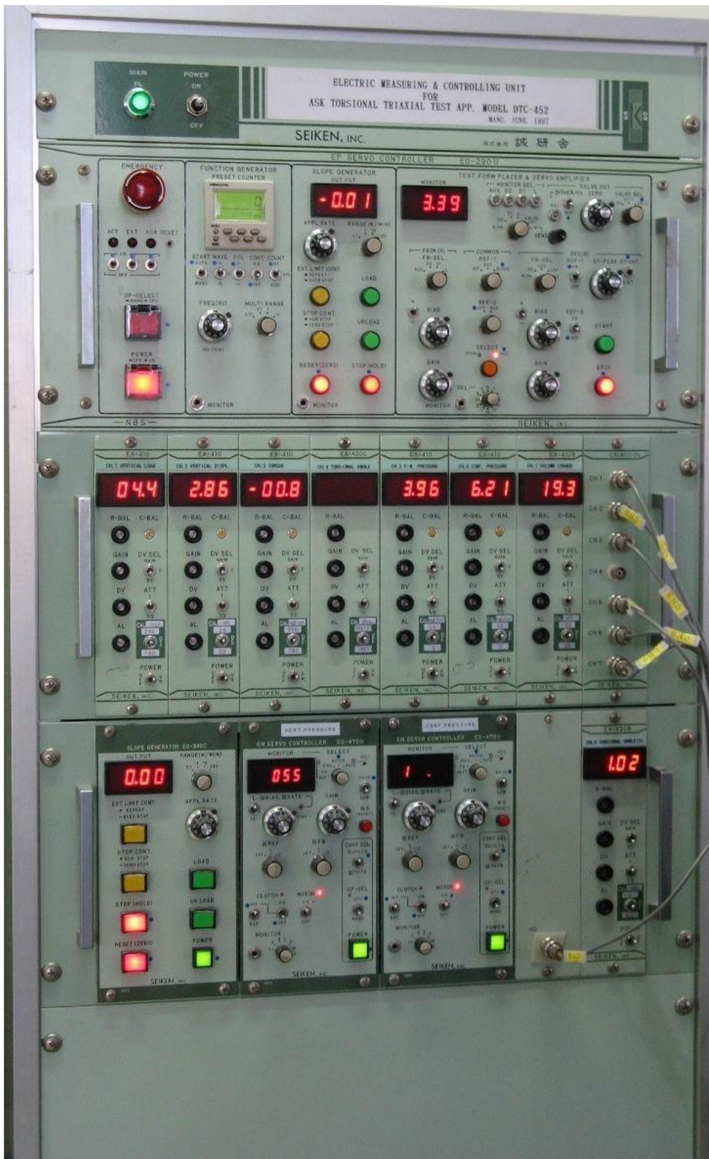
Σχήμα 5.6. Μονάδα ηλεκτρονικού ελέγχου
