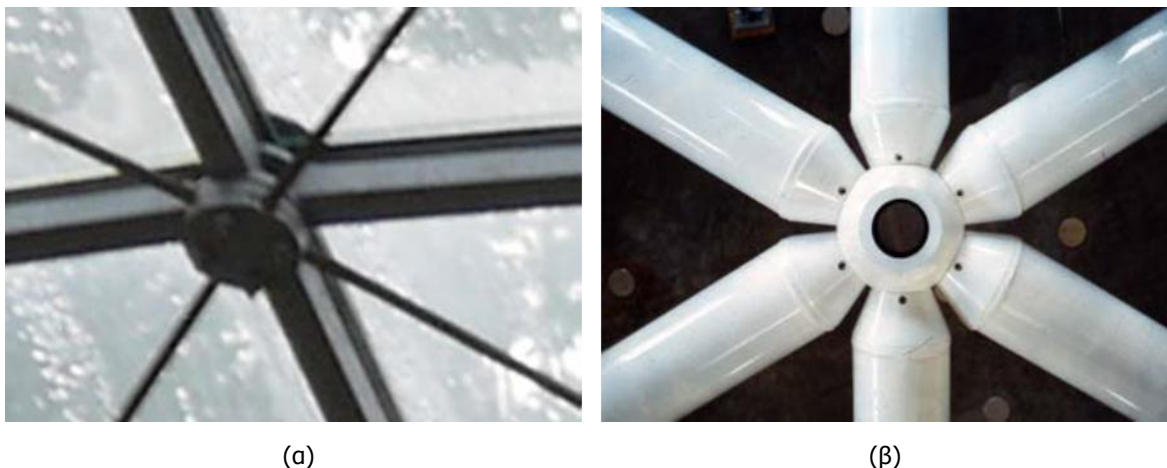
Εικόνα 1.4: Συνδέσεις για μονόστρωτο κέλυφος [1] (α) Άκαμπτη σύνδεση (β) Ημιάκαμπτη σύνδεση
