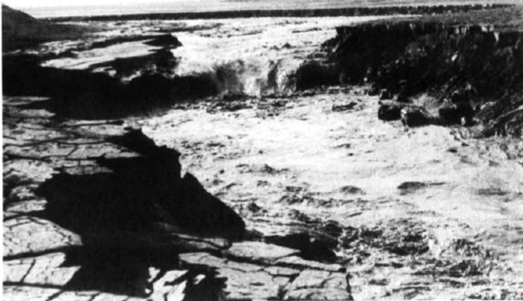
Εικόνα 3.13 Σημείο απότομης αλλαγής κλίσης (nickpoint) στον ταμιευτήρα Sefid-Rud του Ιράν (Tolouie,1993).
