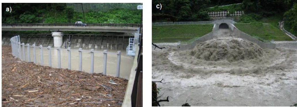
Εικόνα 4.7 Αριστερά, η κατασκευή αποφυγής έμφραξης της εισόδου της σήραγγας. Δεξιά, η κατασκευή καταστροφής της ενέργειας στην έξοδο της σήραγγας.
