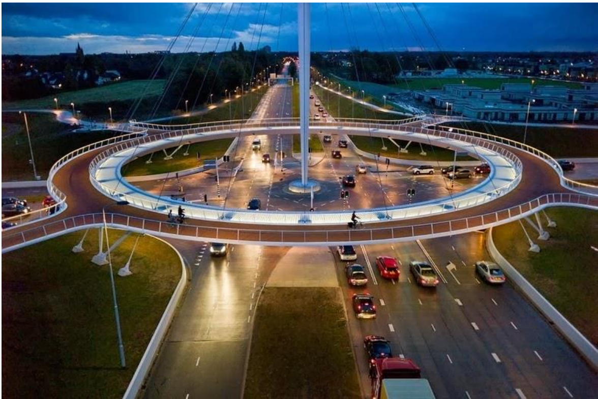
Σχήμα 1.5: Η γέφυρα 'Hovenring' στη πόλη Αϊντχόβεν, Ολλανδία
