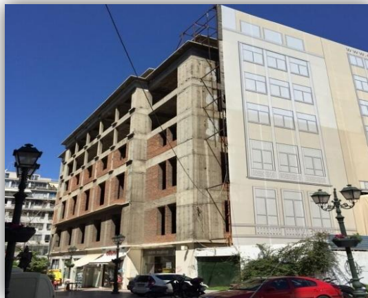
Σχ. 1.1: Εξωτερική φωτογραφική λήψη του κτιρίου
