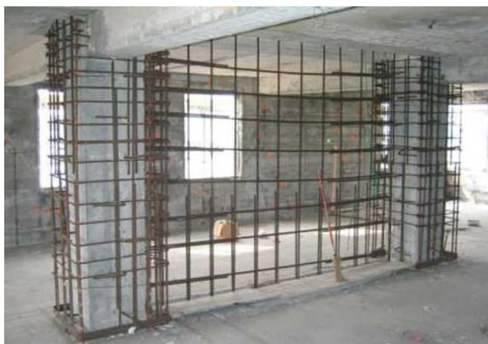
ΣΧ.7.2.: Ενίσχυση με εμφαντούμενο τοίχωμα
