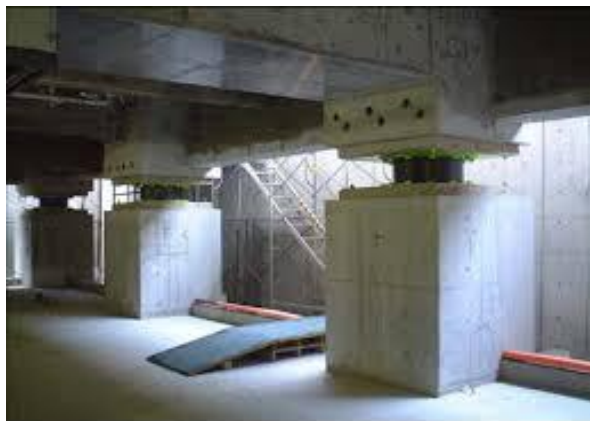
ΣΧ.7.1.: Σεισμική μόνωση κτιρίου
