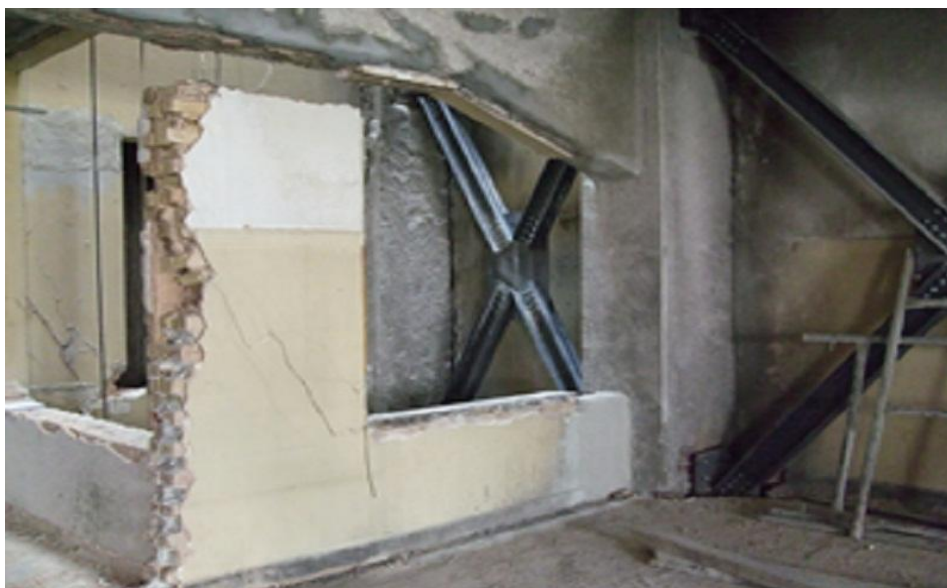
ΣΧ.7.2.: Ενίσχυση με εμφαντούμενο τοίχωμα
