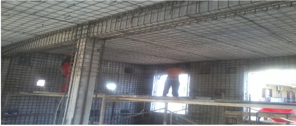
ΣΧ.7.4.: Ενίσχυση με μανδύες εκτοξευόμενου σκυροδέματος
