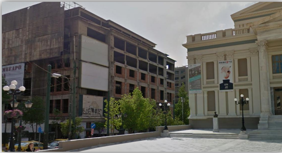
Σχ.4.1: Φωτογραφική λήψη του κτιρίου πριν την κάλυψή του
