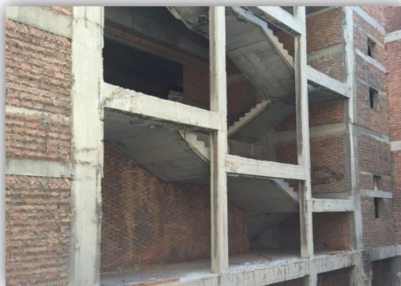
Σχ. 1.2: Εσωτερική φωτογραφική λήψη του κτιρίου
