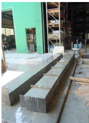
Εικόνα 8.6: Δοκοί μετά την ολοκλήρωση της σκυροδέτησης
