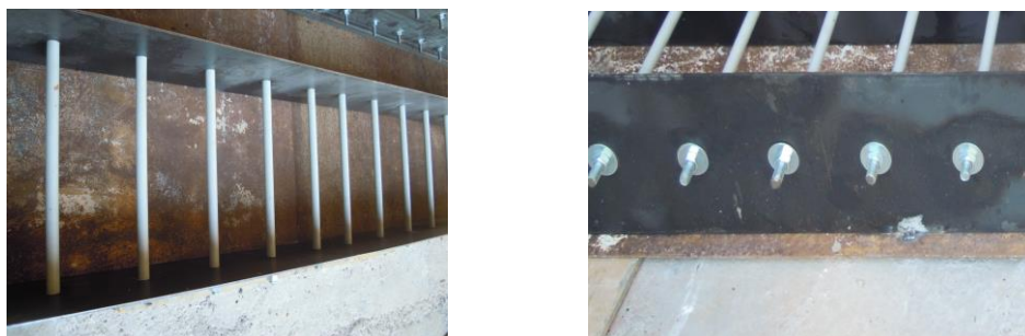
Εικόνα 8.3: Διάταξη κοχλιών Δοκού Β
