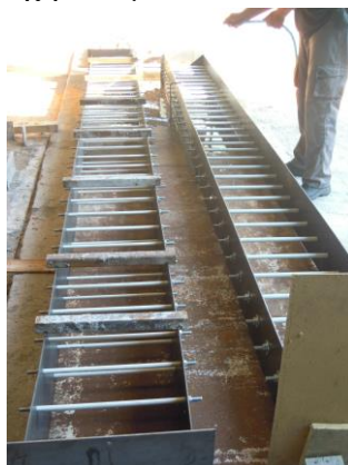
Εικόνα 8.4: Διαβροχή μεταλλοτύπων δοκών
