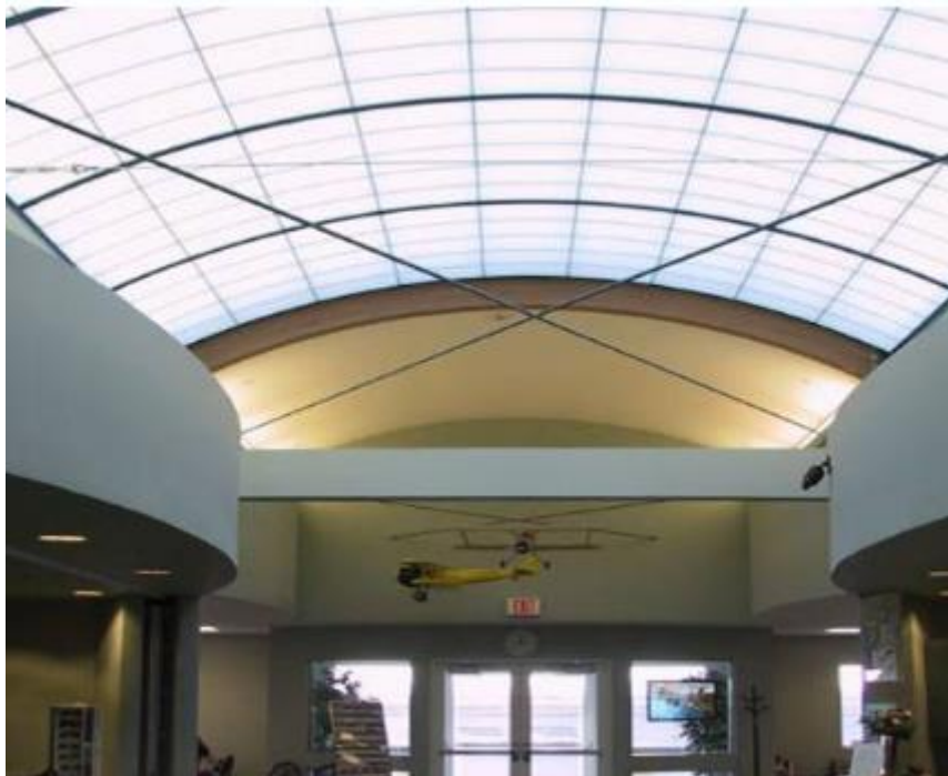
Σχήμα 2.7: Τεχνική Φυσικού Φωτισμού με Ανοίγματα [12]
