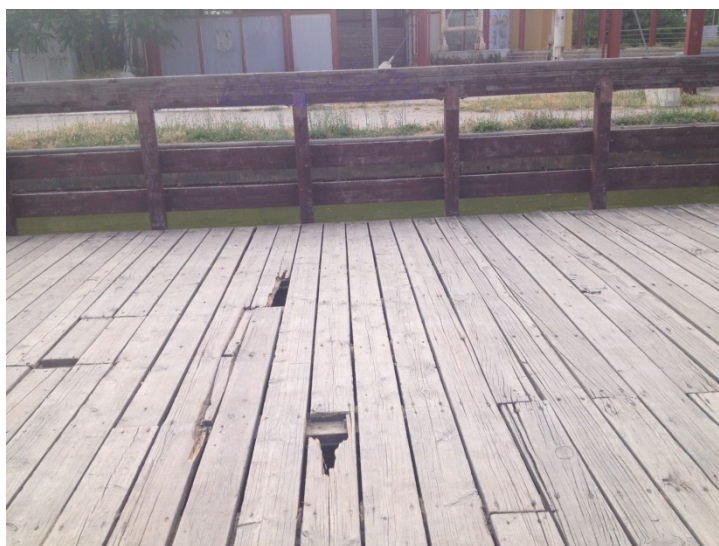
Εικόνα 22. Σπασμένο κομμάτι πεζογέφυρας. Πηγή: Προσωπικό αρχείο
