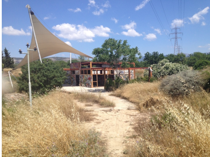
Εικόνα 23. Κτίριο το οποίο έχει υποστεί βανδαλισμούς. Πηγή: Προσωπικό αρχείο
