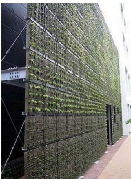
Εικ. 2.7 Ζωντανός τοίχος για την μείωση του θορύβου [Πηγή: 8. Ozger Burhan Timur & Elif Karaca. Vertical Gardens.]
