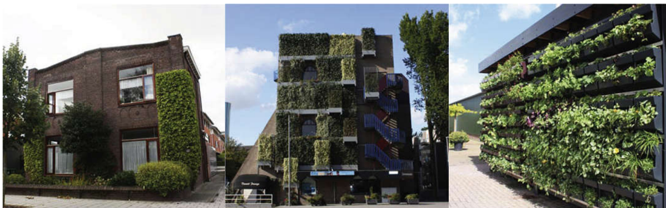
Εικ. 3.20 Άμεσο σύστημα πράσινου τοίχου, (αριστερά) Έμμεσα στηριζόμενο σύστημα πράσινου τοίχου (μέση), Σύστημα ζωντανού τοίχου (δεξιά) [Πηγή: 7.Katia Perini & Marc Ottel & A.L.A. Fraaij & E.M. Haas & Rossana Raiteri. Vertical greening systems and the effect on air flow and temperature on the building envelope.]
