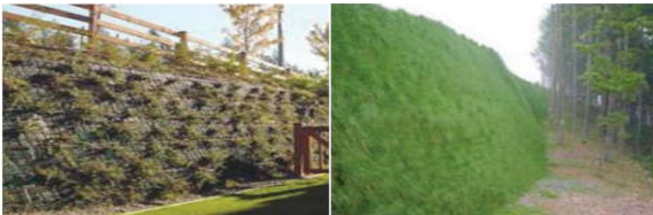
Εικ. 3.18 Φυτικός τοίχος πριν την ανάπτυξη των φυτών (αριστερά) μετά από την ανάπτυξη των φυτών (δεξιά) [Πηγή: 15. Μουντρίχας Γ.. Συμβολή της φυτοκάλυψης στο μικροκλίμα κτιριακών συγκροτημάτων στο αστικό ιστό.]
