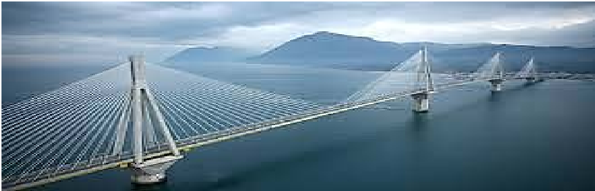
Εικόνα 1.13 : Γέφυρα Χαρίλαος Τρικούπης
