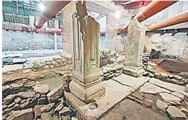
Εικόνα 1.11: Κατασκευή Μετρό Θεσ/νίκης
