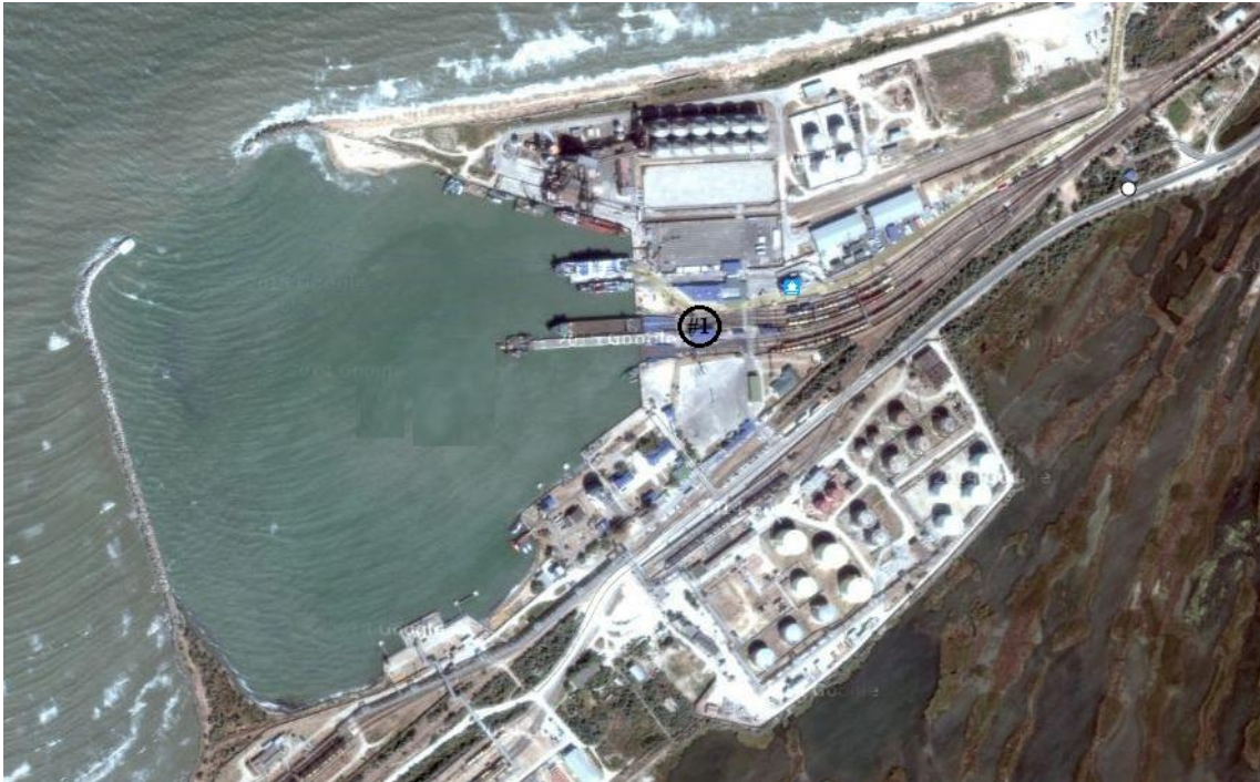
Εικόνα 35: Το σιδηροδρομικό πορθμείον του λιμένα Kavkaz (67)
