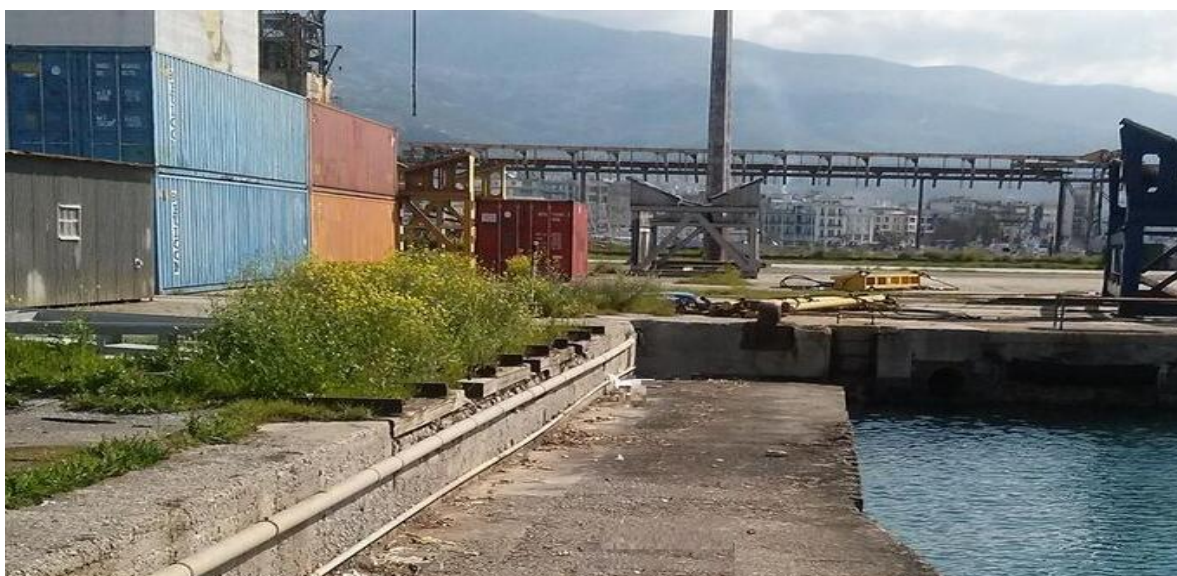
Εικόνα 33: Σημερινή κατάσταση σιδηροδρομικού πορθμείου στο λιμένα Βόλου
