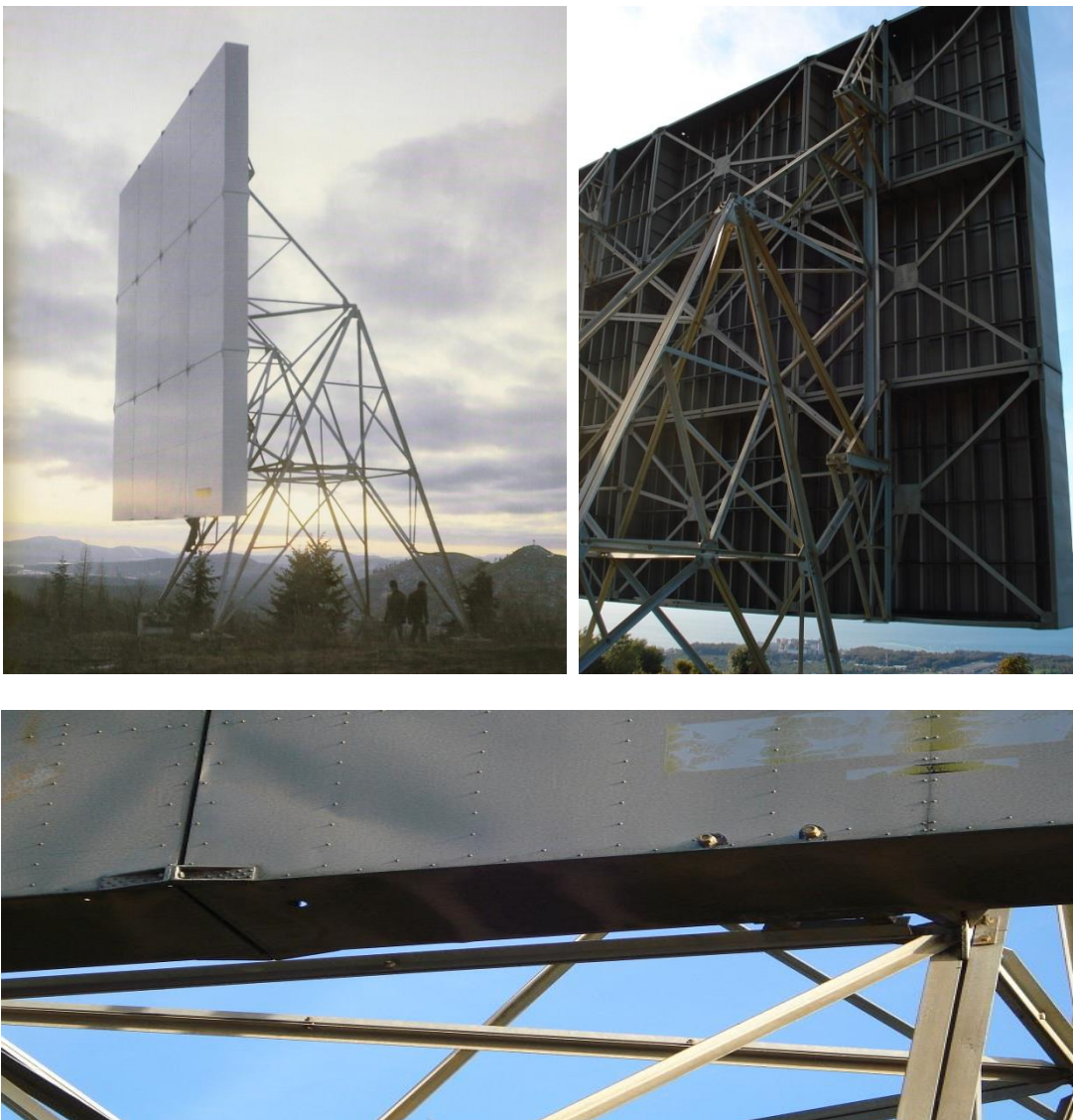
Σχήμα 2.5: Ενδεικτικές περιπτώσεις παθητικών κατόπτρων με εμφανή τη χρήση γωνιακών διατομών για τη στήριξή τους
