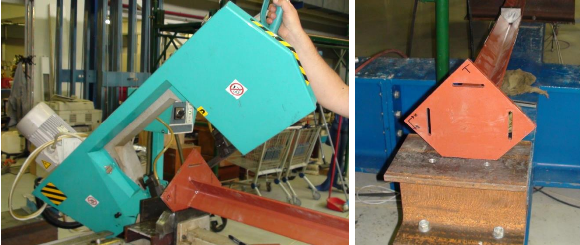
Σχήμα 6.1: Κοπή πλάκας απόληξης γωνιακού (αριστερά) και τελική τοποθέτηση μέλους (δεξιά)
